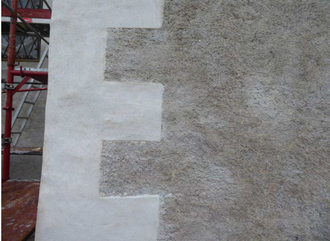
Bild 11 oben: Detailansicht Fassadenfläche der Sakristei nach Abnahme der Farbe und Abschluss der Putzergänzung. Bild 12 unten: Detailansicht Fassade Südost vor Beginn der Arbeiten. Vorgabe der Putzergänzungen am histor. Bestand ist ein noch gut erhaltener Putzbereich der got. Architekturoberfläche an einem der östl. Pfeiler.
