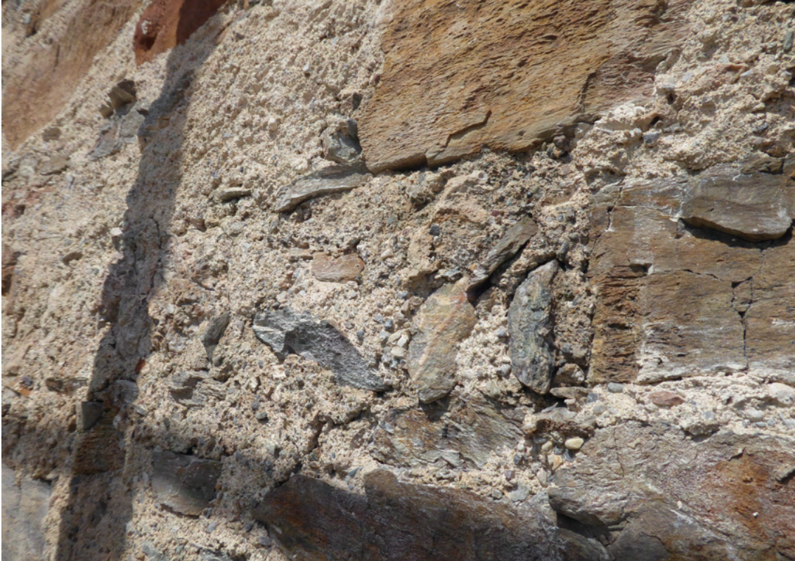
Bild 38 oben Turmseite West: Detailansicht des wieder geschlossenen Mauerwerkverbundes Bild 39 unten Turmseite West; nach Abschluss der Maßnahmen im September (siehe auch Detailansicht Schadensbild Seite 18 Pfeil blau).
