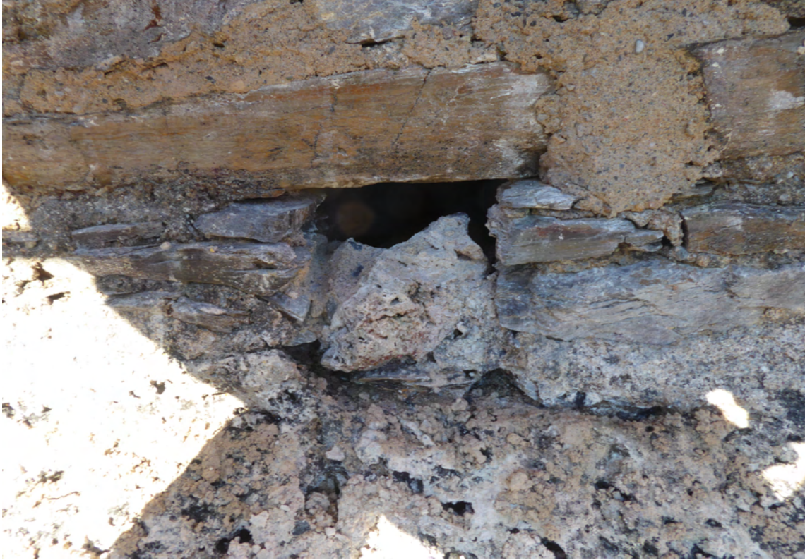
Bild 10 oben: Verschlussene Öffnung der Dachentwässerung des Glockengestühls in der Höhe des Daches zum Langhaus aus einer der letzten Renovierungsphasen (vermutl. um 1900, Verwendung von Romankalk), siehe auch Gesamtansicht Bild 11 unten).
