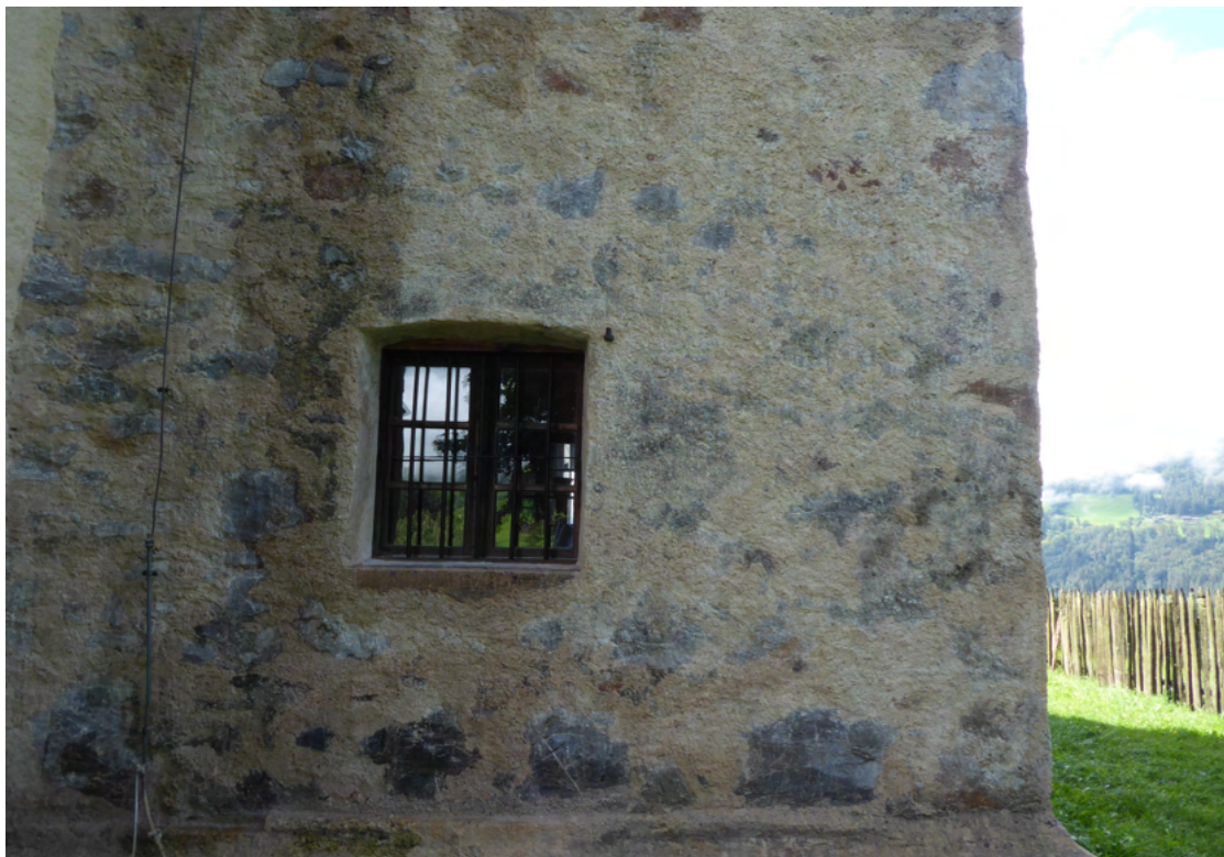
Bild 30: Detailansicht EG Mauerfläche Ost nach Angleichung der Textur zum gealterten Bestand des Mauerwerks. Bild 31 unten: Detailansicht Turmseite Ost nach Ausgerüstung und partieller Retusche der Ergänzungen (dunkle Flächen sind Stein und orig. bauzeitl. Sichtputzlage).
