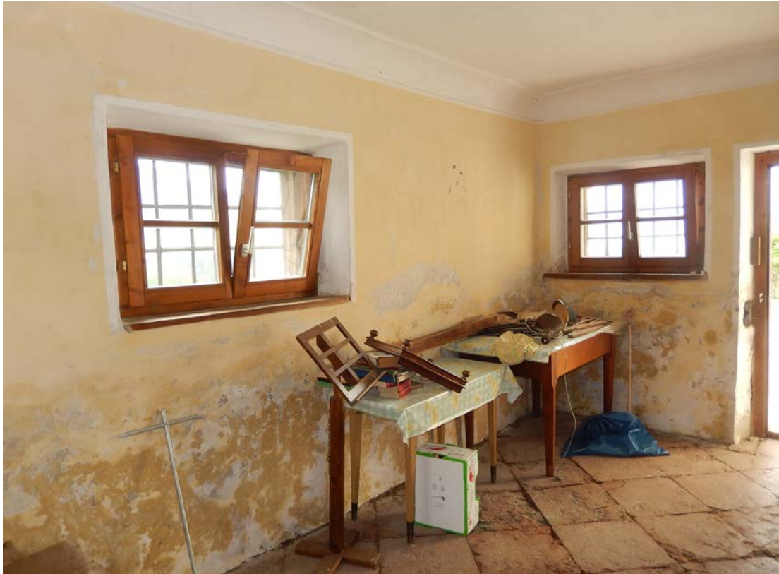
Bild 8 oben: Sakristei Ansicht Wandfläche Süd vor den Restaurierungsmaßnahmen(u.a. Erneuerung Sockelputz). Bild 9 unten: Nach der Abnahme des Sockelputzes(Zementputzlagen der letzten Renovierungsphase) u. Einzug der E-Installation erfolgte eine Austrocknungsphase von 3 Wochen
