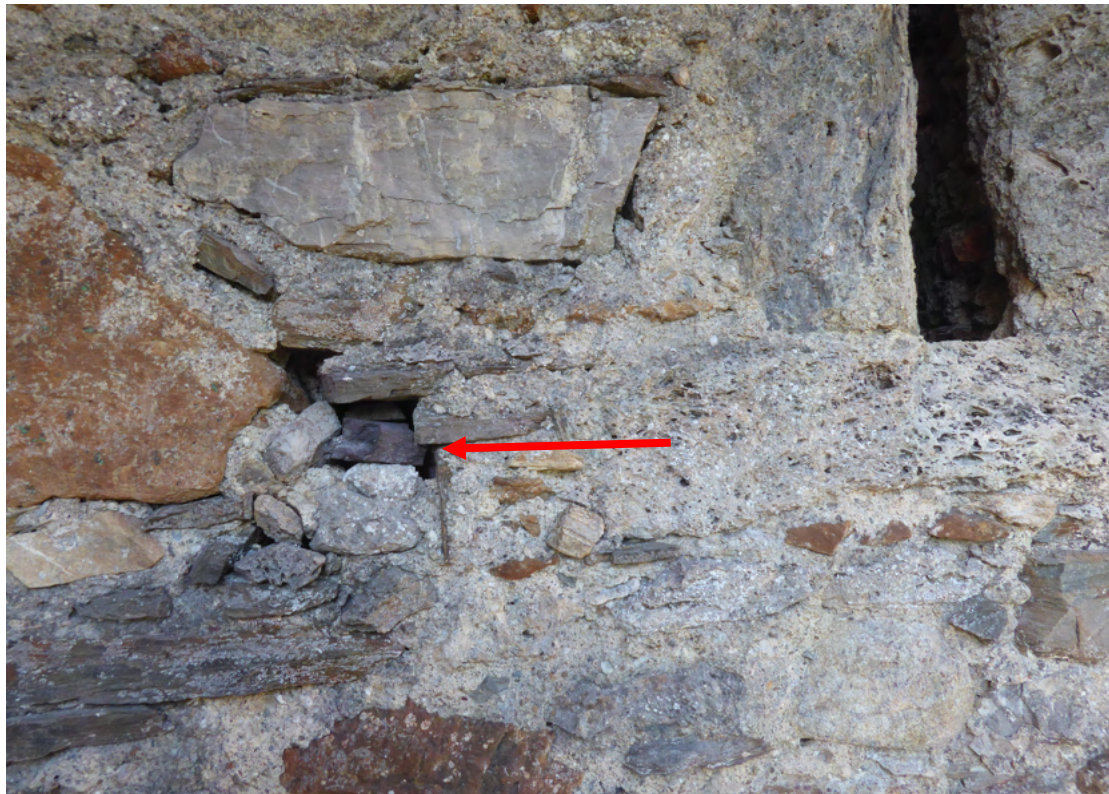
Bild 6 oben: Bauzeitliche Maueröffnung Turmseite Nord( u.a. werkstechnischen Auflager für die bauzeitl. Gerüstung). Bild 7 unten Detailansicht Turmseite Ost: Provisorisch geschlossenen Maueröffnung aus der Erbauungszeit(siehe Pfeil rot).
