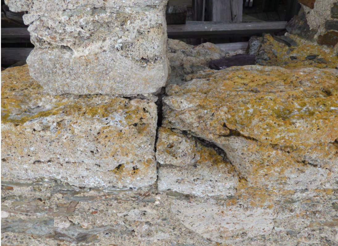
Bild 18 oben Detailansicht Schallöffnung Süd mit Algenbefall u. Schäden des Mauerwerkverbundes. Bild 19 unten Detailansicht umlaufendes erstes Gesimse Nordwest vor den Reinigungsmaßnahmen.
