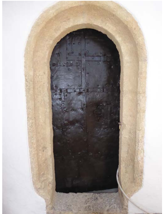
Bild 14 Portal und Türblatt zum Turmzimmer nach Abschluss der Arbeiten im September 2018
