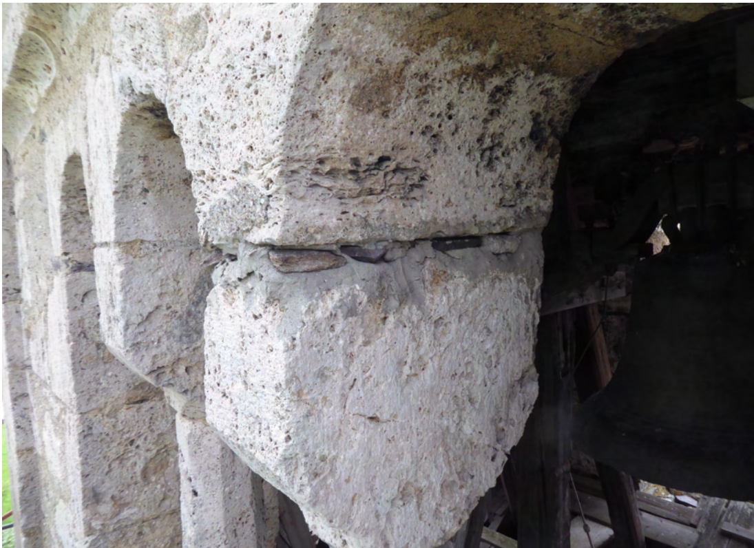
Detailansicht mittleres Gesimse Südseite Bild 20 vor den restaurator. Maßnahmen. Bild 21 Detailansicht Turmseite Nord mit Ausbesserungen der Fugen am Rundbogenfensters/Kapital aus der letzten Renovierungsphase.
