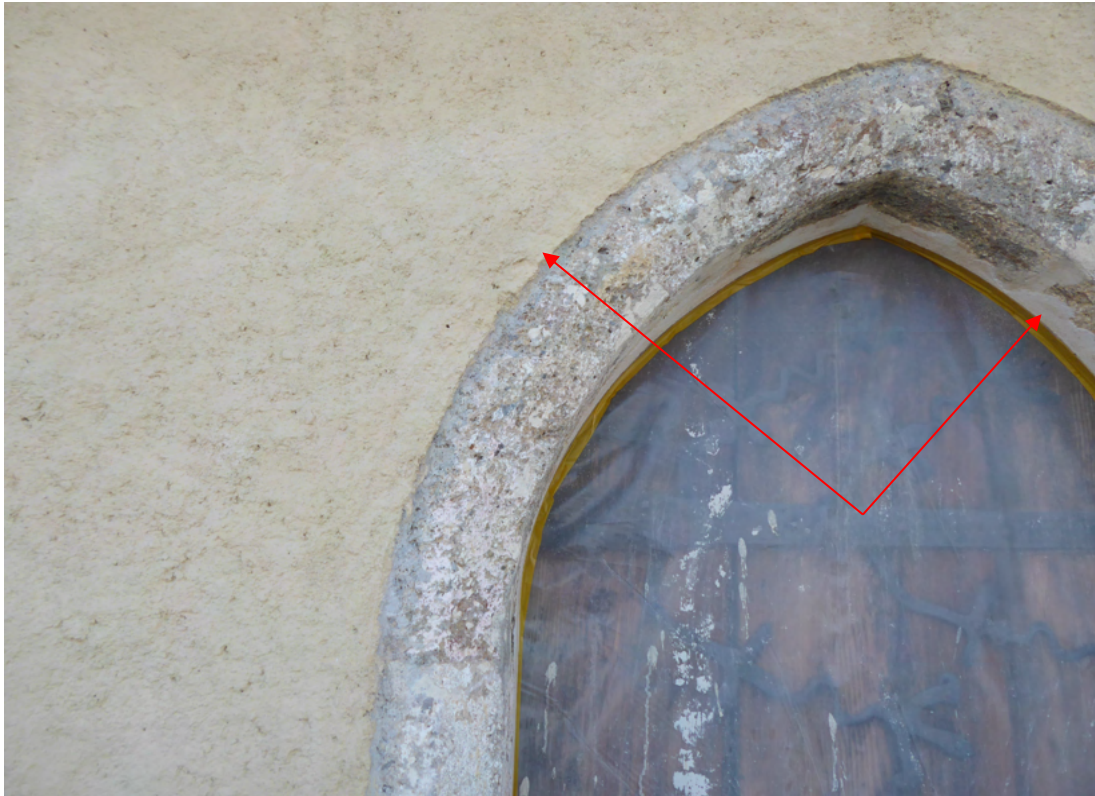
Bild 17: Detailansicht Eingangsbereich Westfassade. Die Putzanschlüsse zum Blindstock werden erneuert, eine opt. Absetzung des Natursteinportals zur Fassadenfläche mit einer geglätteten Putzfache wird angedacht. Bild 18 unten: Detailansicht Eingangsportal West nach Abschluss der Maßnahmen vor der Ausgerüstung im September.
