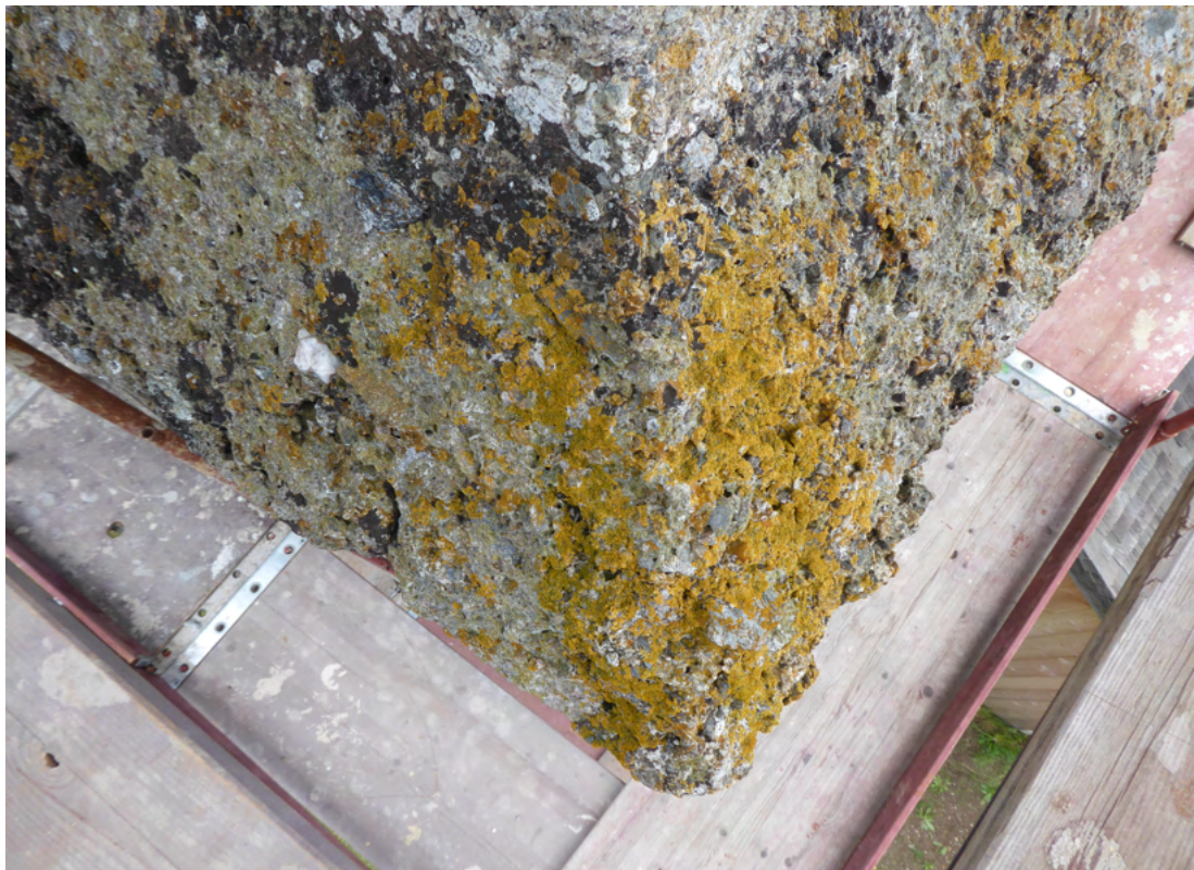
Bild 18 oben Detailansicht Schallöffnung Süd mit Algenbefall u. Schäden des Mauerwerkverbundes. Bild 19 unten Detailansicht umlaufendes erstes Gesimse Nordwest vor den Reinigungsmaßnahmen.
