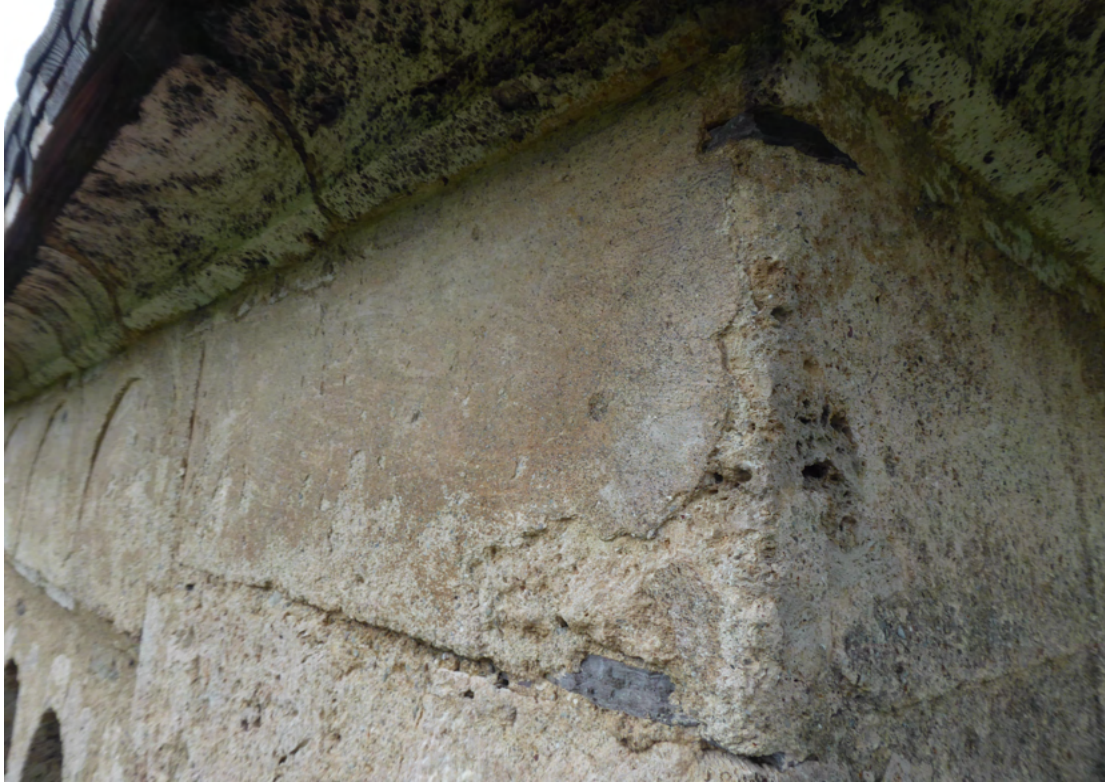
Bild 4 oben Detailansicht Südost: intakten Fassungsträgers am Bogenfries oberhalb der Schallöffnungen. Bild 5 unten Detailansicht Rundbogenfries Süd: Polychromie mit vermutl. ersten Gestaltungsphase(Ocker/Weißfassung).
