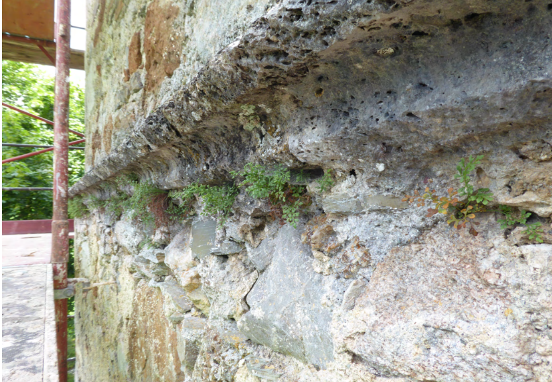
Bild 16 oben Detailansicht Turmseite Nord: Pflanzenbewuchs unterhalb des ersten umlaufenden Gesimses. Bild 17 unten Detailansicht Sockelbereich Ost mit abgestorbenen Wurzelresten im Mauerwerk.
