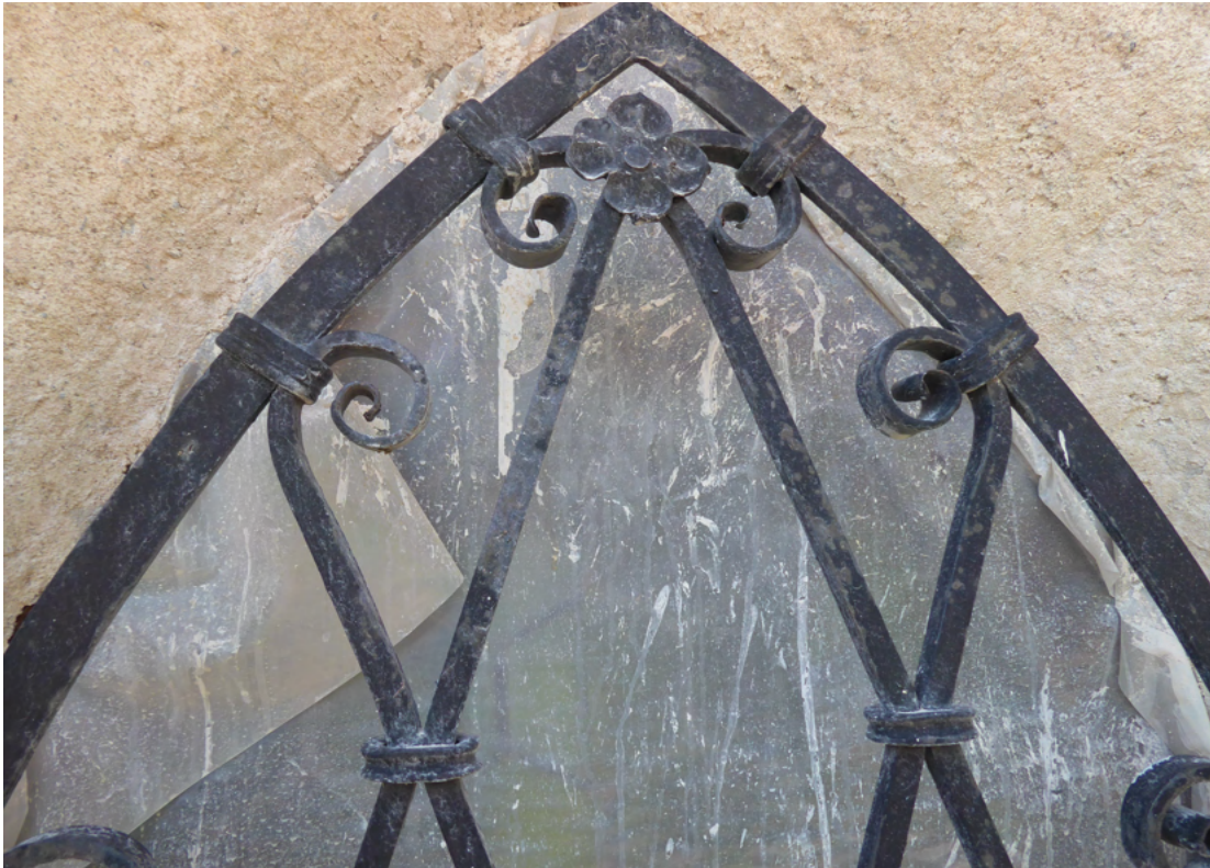
Bild 19 oben: Detailansicht Gitter, Spitzbogen über der Sakristei vor Reinigung und Anstrich mit pigmentiertem Öl Bild 20 unten: wie Bild oben nach Abschluss der Maßnahmen im September.
