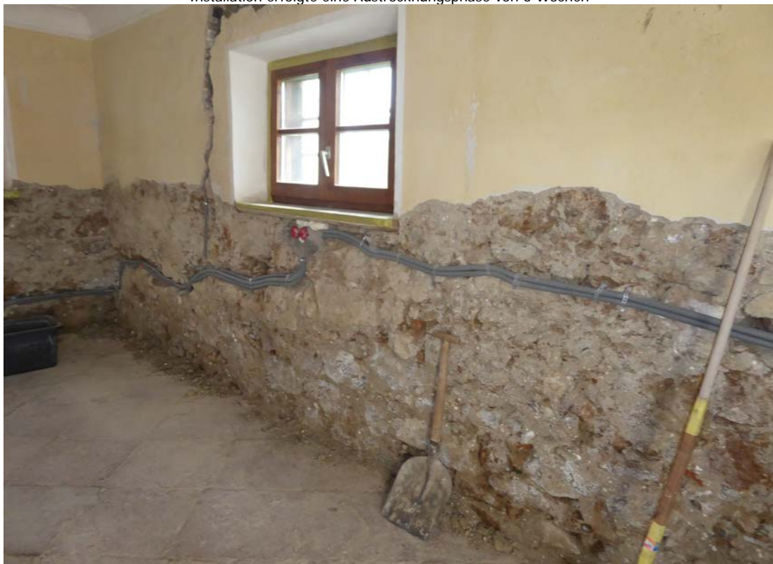
Bild 8 oben: Sakristei Ansicht Wandfläche Süd vor den Restaurierungsmaßnahmen(u.a. Erneuerung Sockelputz). Bild 9 unten: Nach der Abnahme des Sockelputzes(Zementputzlagen der letzten Renovierungsphase) u. Einzug der E-Installation erfolgte eine Austrocknungsphase von 3 Wochen
