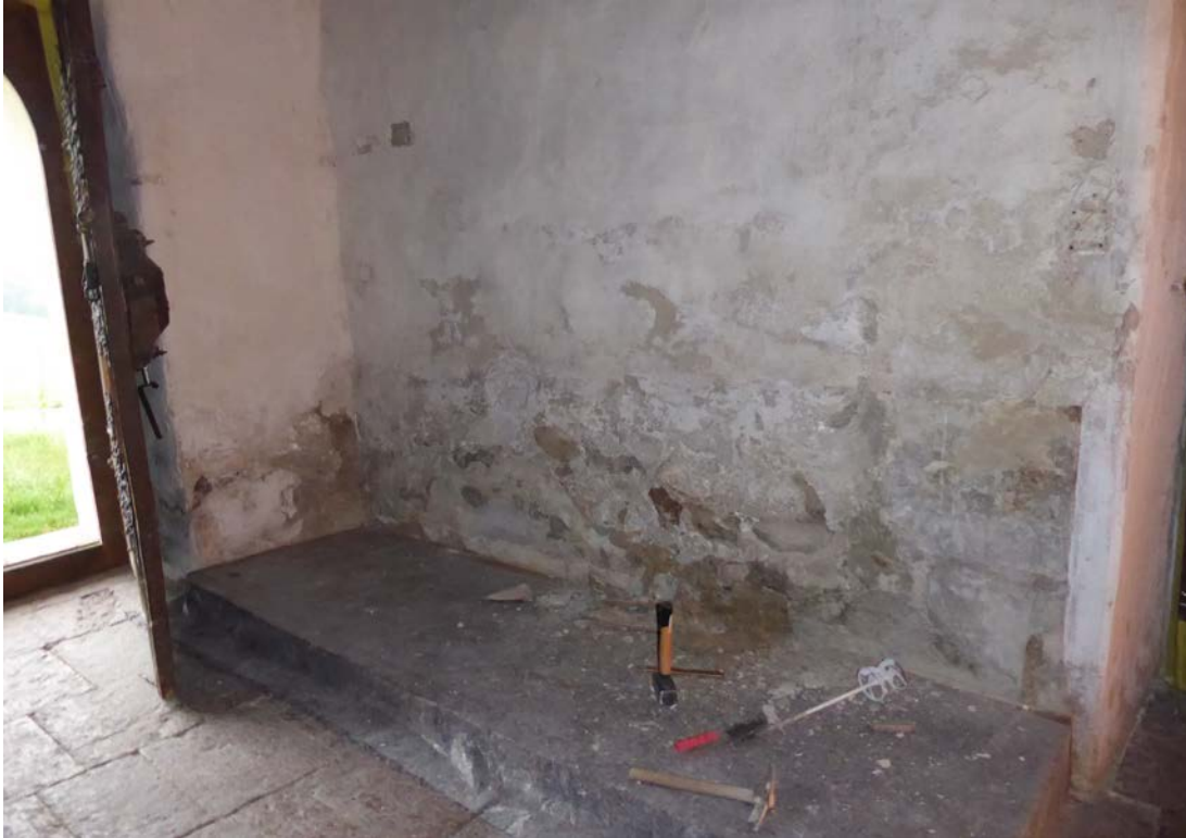
Bild 3 oben: Referenzbereich Eingang Wandfläche Südwest, Abnahme Zementputz Sockelbereich Bild 4 unten: Referenzbereich Wandfläche Südwest, Grundputz gerappt (Pfeile rot) anschl. bündiges schließen mit Kalkfeinputz (rechte Bildhälfte).
