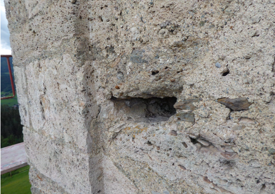
Bild 6 oben: Bauzeitliche Maueröffnung Turmseite Nord( u.a. werkstechnischen Auflager für die bauzeitl. Gerüstung). Bild 7 unten Detailansicht Turmseite Ost: Provisorisch geschlossenen Maueröffnung aus der Erbauungszeit(siehe Pfeil rot).
