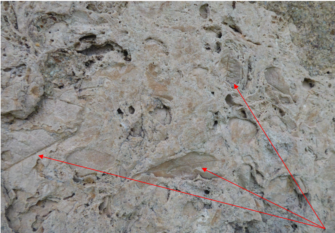
Bild 14 Detailansicht Eckquaderung im obersten Bereich des Turmes: Verwendung von Kalktuff(siehe Detail des eingelagerten, versinterten Blattwerks).
