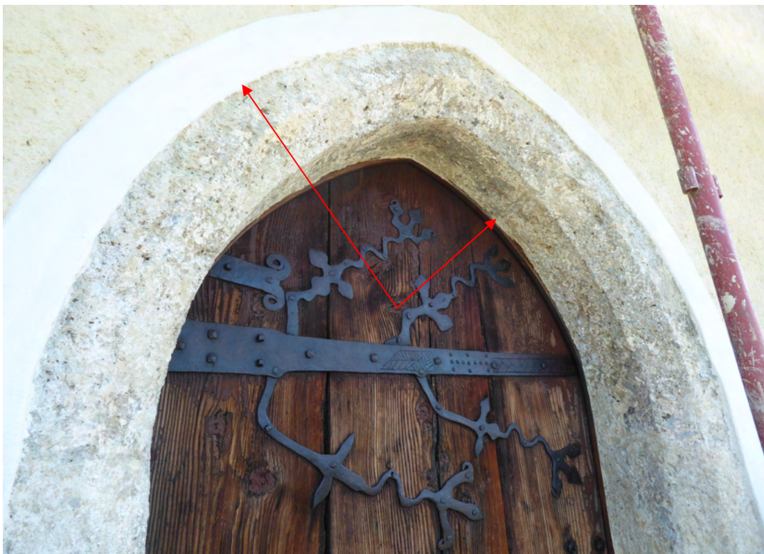
Bild 17: Detailansicht Eingangsbereich Westfassade. Die Putzanschlüsse zum Blindstock werden erneuert, eine opt. Absetzung des Natursteinportals zur Fassadenfläche mit einer geglätteten Putzfache wird angedacht. Bild 18 unten: Detailansicht Eingangsportal West nach Abschluss der Maßnahmen vor der Ausgerüstung im September.
