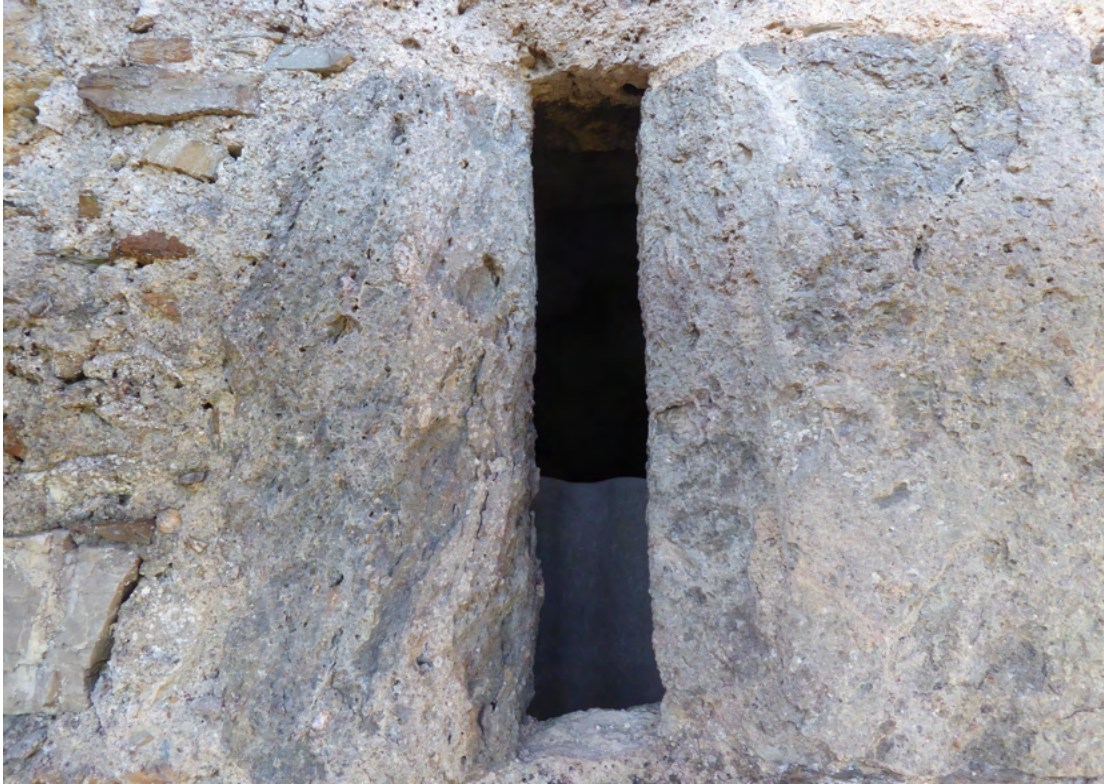
Bild 8 oben Detailansicht Turmseite Ost: Die schartenartig, abgefasten Fensteröffnungen wurden jeweils aus 4 Steinen zusammengefügt.
