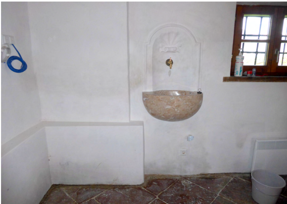
Bild 45 oben und Bild 46 unten: Einbau des Lavabos in der Sakristei. Hierfür wurde der Bereich für den Stein ausgestemmt und nach Montage wieder eingeputzt inkl. Anbindung der Stuckprofile und Feinputz. Fassung des Bereiches mit Kalktünche laut Bestand.
