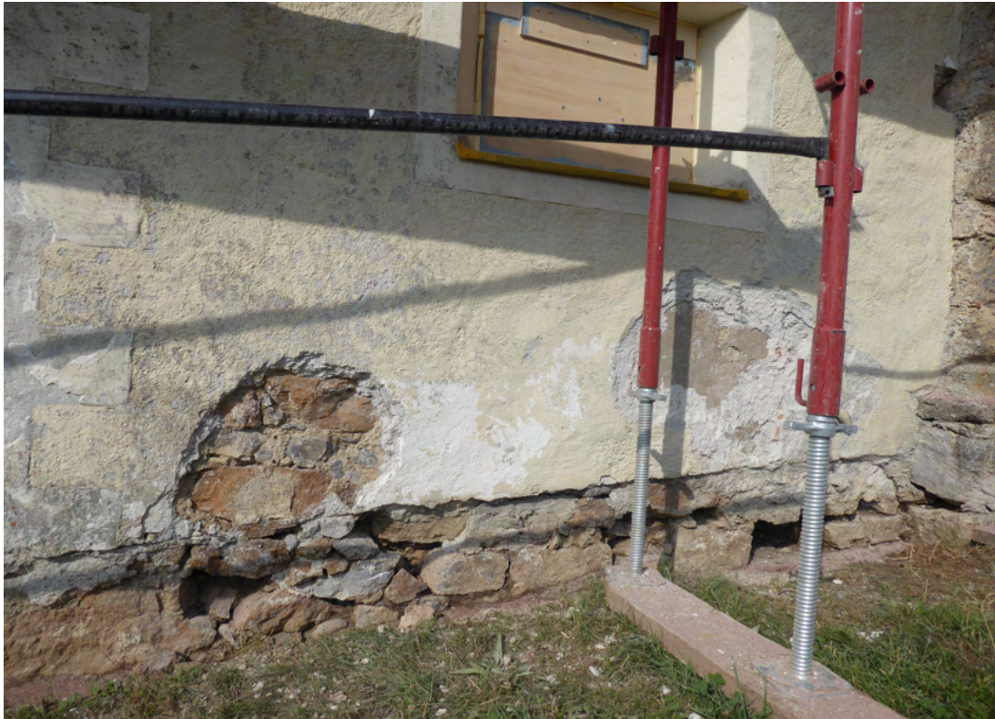
Bild 9 oben: Abnahme loser Putztaschen, Zementausbesserungen und Vorreinigung Sockelbereich zur Rückseite der Sakristei. Bild 10 unten: Beginn der Putzausbesserungen mit gleichwertigem Material.
