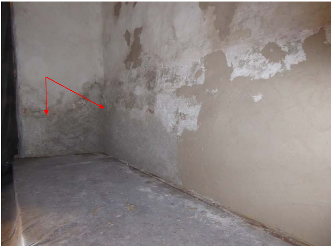
Bild 3 oben: Referenzbereich Eingang Wandfläche Südwest, Abnahme Zementputz Sockelbereich Bild 4 unten: Referenzbereich Wandfläche Südwest, Grundputz gerappt (Pfeile rot) anschl. bündiges schließen mit Kalkfeinputz (rechte Bildhälfte).
