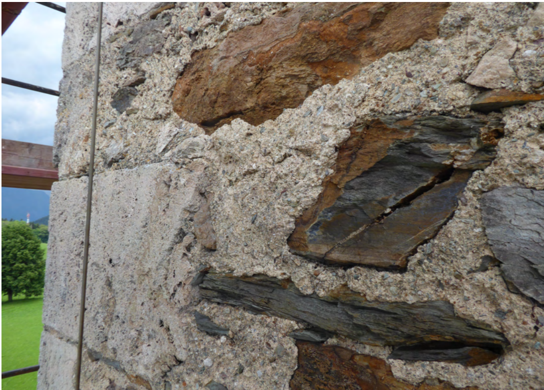
Bild 9 unten: Abmauerung der zusammenlaufenden Mauerflächen mit abgefasten Eckquadern(Kalktuff/Rauwacke), das restl. Mauerwerk wurde mit Bruchstein aufgezogen(Ausnahme das oberste Turmsegment mit den Schallöffnungen).
