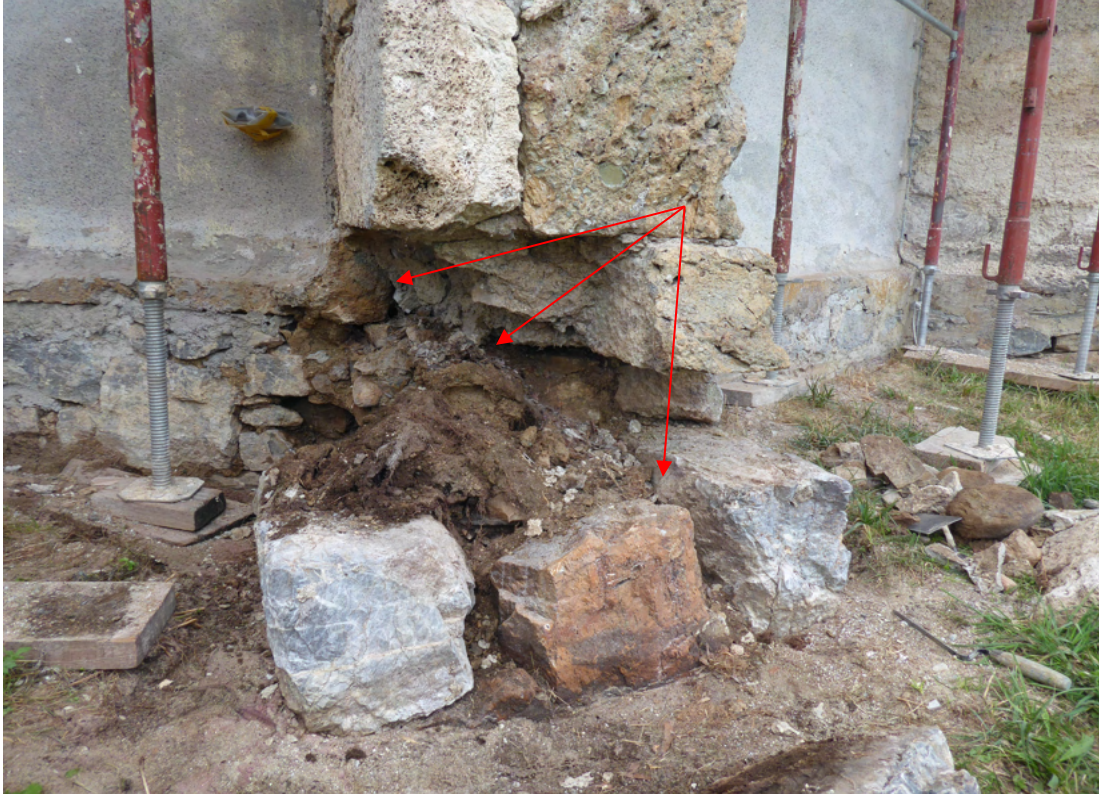
Bild 14 oben: Sockelbereich Pfeiler Südost während der Restaurierungsmaßnahmen. Der Fugen- und Setzmörtel des unteren Sockelfundamentes war durch eindringendes Regenwasser und dem Pflanzenbewuchs erheblich reduziert das Bruchsteinmauerwerk löste sich aus dem Mauerwerksverbund.
