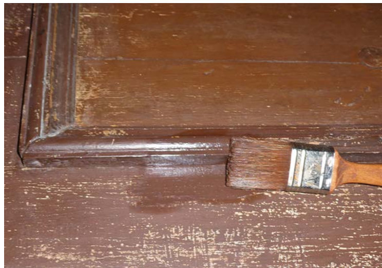
Bild 23 oben: Ansetzen des pigmentierten Ölstriches nach Vorgabe des Bestandes und Neufassung des Türblattes(Einseitig zur Seite Chor, die Rückseite des Türblattes in monochromer, holzsichtigen leicht pigmentierter Ölfassung)
