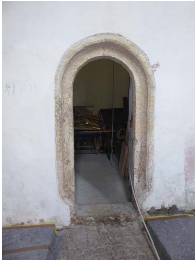
Bild 13 Portal zum Turmzimmer: Vorzustand Juli 2018
