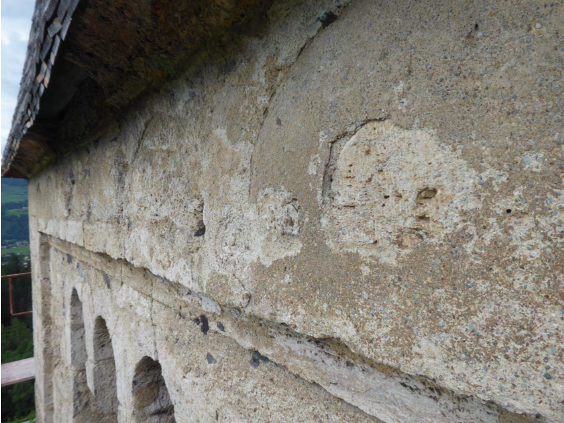
Bild 15:Detailansicht Turmseite Süd, Bogenfries über den Schallöffnungen vor den Maßnahmen
