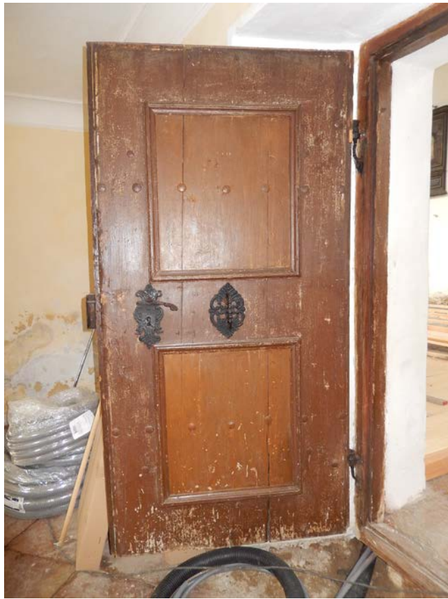
Bild 21: Türblatt Sakristei Vorzustand Juli 2018
