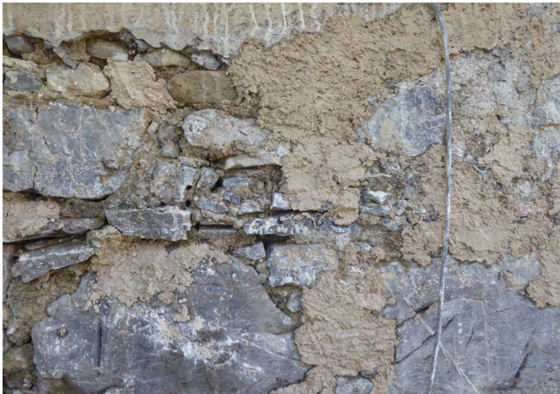
Bild 28 Detailansicht EG Turmseite Ost mit „Anböschung“ der offenen Putzfugen, nachfolgend werden der reduzierte Setz- und Fugenmörtel wieder bündig zum Bruchstein geschlossen, ein weiteres eindringen von Regenwasser ist unterbunden (Bild 29).
