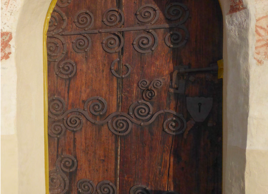
Bild 23 oben: Detailansicht Türblatt Eingangsbereich Süd nach der Reinigung und Neufassung mit Leinöl.
