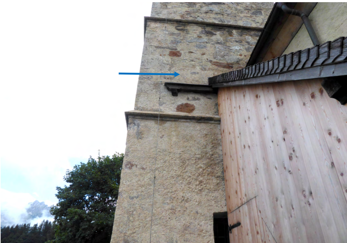
Bild 38 oben Turmseite West: Detailansicht des wieder geschlossenen Mauerwerkverbundes Bild 39 unten Turmseite West; nach Abschluss der Maßnahmen im September (siehe auch Detailansicht Schadensbild Seite 18 Pfeil blau).
