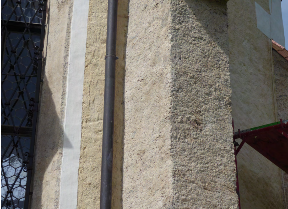
Bild 16: Detailansicht Pfeiler und Rahmung Fenster Südost während der Ausgerüstung im September 2019. Pigmentierte Kalktünchefassung der Fassadenflächen und restaurierter Pfeiler. Die Textur und Farbigkeit der Putzergänzungen wurden dem Bestand angeglichen. Eine optische Angleichung der Neuverputzungen mit einer Retusche mit Aqua Sporca (Bindemittel 10% Syton/Kieselsäuredispersion in Wasser) bildete den Abschluss der Maßnahmen.
