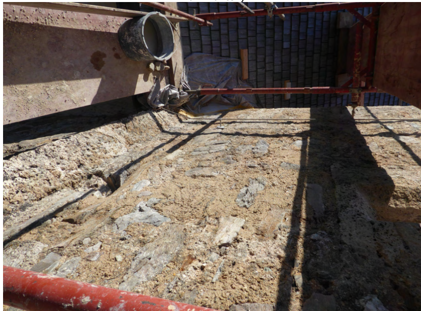
Bild 10 oben: Verschlussene Öffnung der Dachentwässerung des Glockengestühls in der Höhe des Daches zum Langhaus aus einer der letzten Renovierungsphasen (vermutl. um 1900, Verwendung von Romankalk), siehe auch Gesamtansicht Bild 11 unten).
