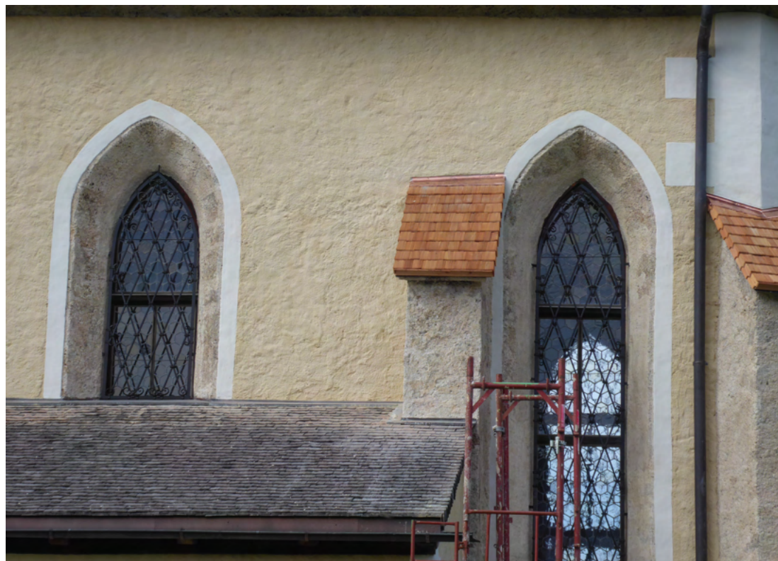
Bild 7: Referenzbereich Wandfläche Süd, Detailbereich Laibung der Fenster über Sakristei im Vorzustand mit den Zementausbesserungen im oberen Spitzbogen. Bild 8 unten: Nach Abschluss der Maßnahmen, Risschließung, Angleichung der Textur und Farbe mit Kalkschlämme und Aqua Sporca.
