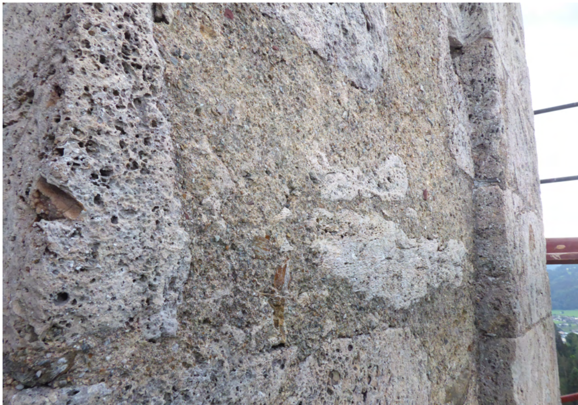
Bild 12 oben Detailansicht Turmseite Süd und Bild 13 unten Turmseite Nord im Bereich der Schallarkaden mit intakter, erhaltener Architekturoberflächen aus der Bauzeit.
