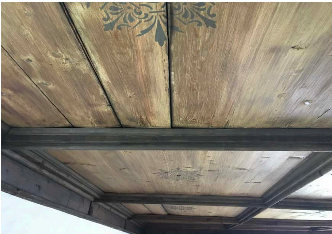
Bild 15 oben: Fassungssehäden an den Profilrahmen der Kassettendecke durch eindringendes Regenwasser Bild 16 unten: Retusche des gereinigten Bereiches
