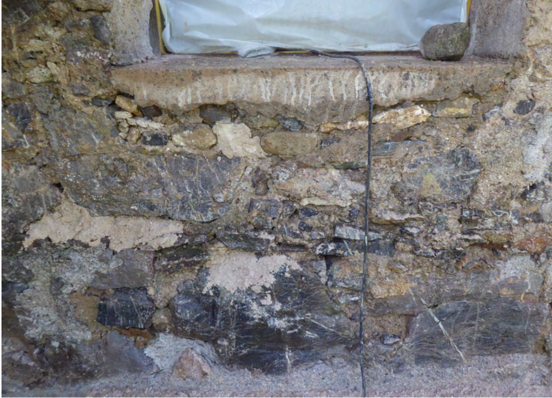
Bild 28 Detailansicht EG Turmseite Ost mit „Anböschung“ der offenen Putzfugen, nachfolgend werden der reduzierte Setz- und Fugenmörtel wieder bündig zum Bruchstein geschlossen, ein weiteres eindringen von Regenwasser ist unterbunden (Bild 29).
