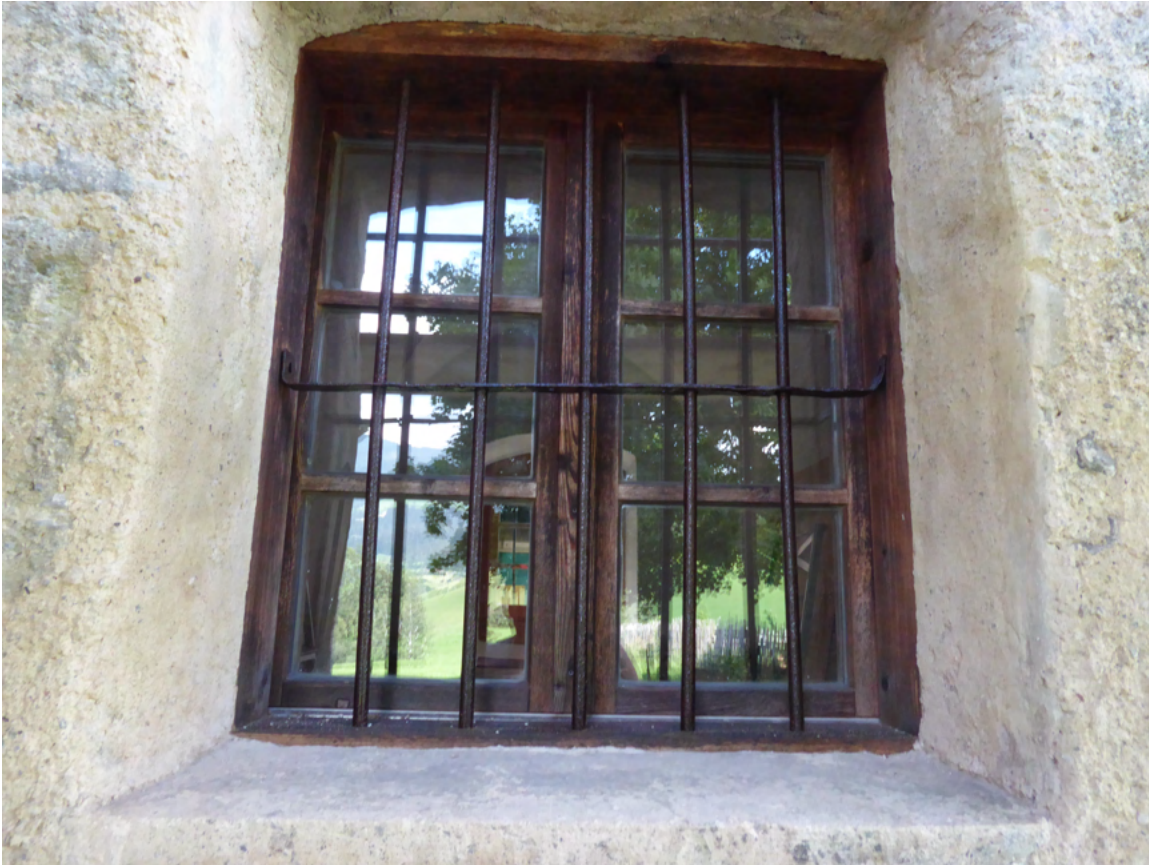
Bild 44 oben: Fenster des Turmzimmers Ost: Beide Fenster des Turmzimmers wurden gereinigt, Rahmen, Außenflügel und Gitter wurden anschließend mit Leinöl gestrichen.
