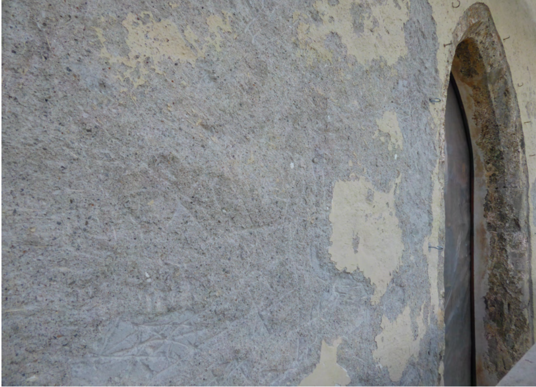
Bild 3 oben: Referenzbereich Eingang Westfassade, Abnahme loser Putzflanken und Farbschollen vor dem Sandstrahlen. Bild 4 unten: Referenzbereich Westfassade nach den Sandstrahlarbeiten und Putzergänzungen der Flächen und Eckquaderungen, in linken Bildseite die erste Musterfläche mit Reinsilikatanstrich wie Bestand der Letztfassung.
