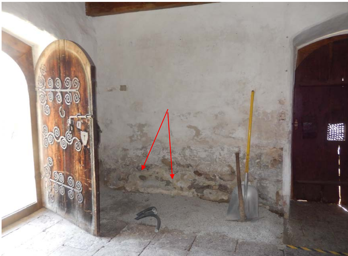
Bild 2: Wandfläche Eingangsbereich Südwest: Ausbesserung des Sockelputzes
