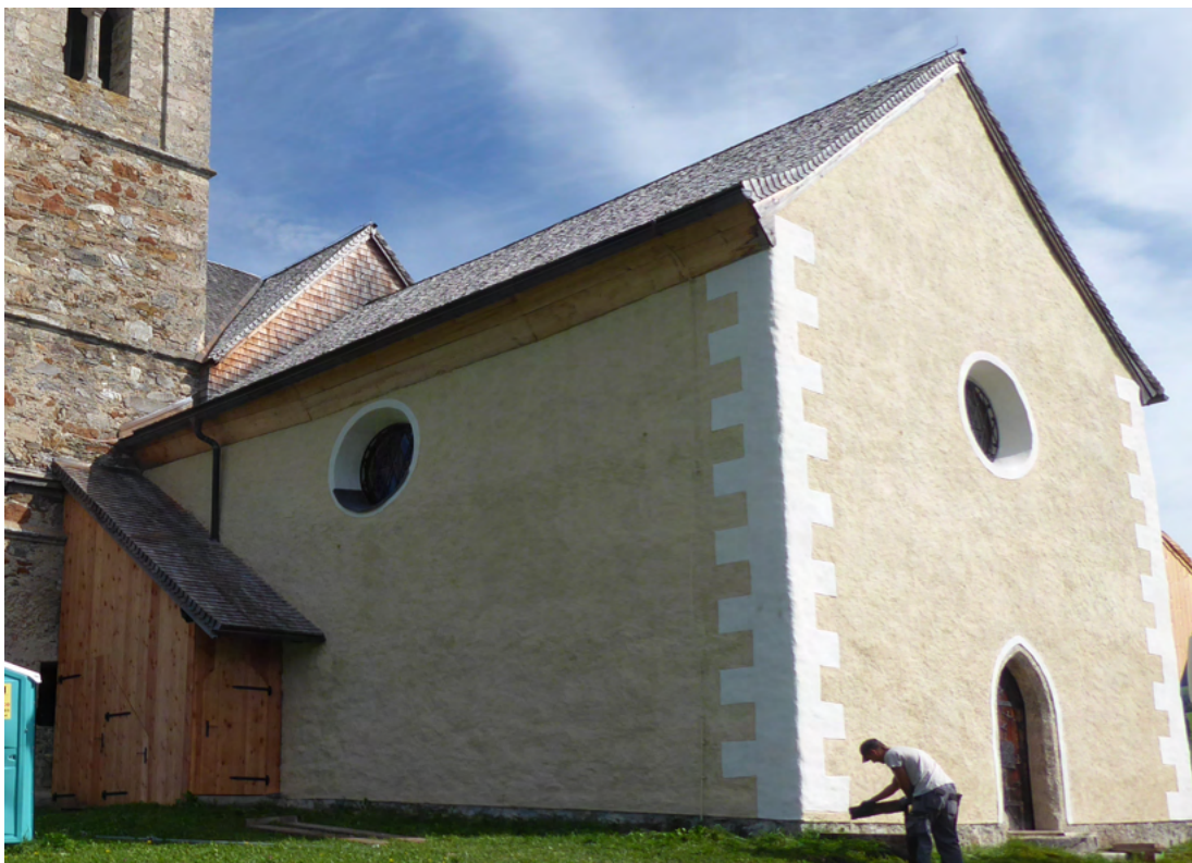
Bild 5 oben: Ansatz von mehreren Farbmusterflächen in reinem pigmentiertem Kalk und Zuschlag von 10% Steinmehl und 5% Plastorit. Bild 6 unten: Langhaus von Nordwest nach der Ausgerüstung im September.
