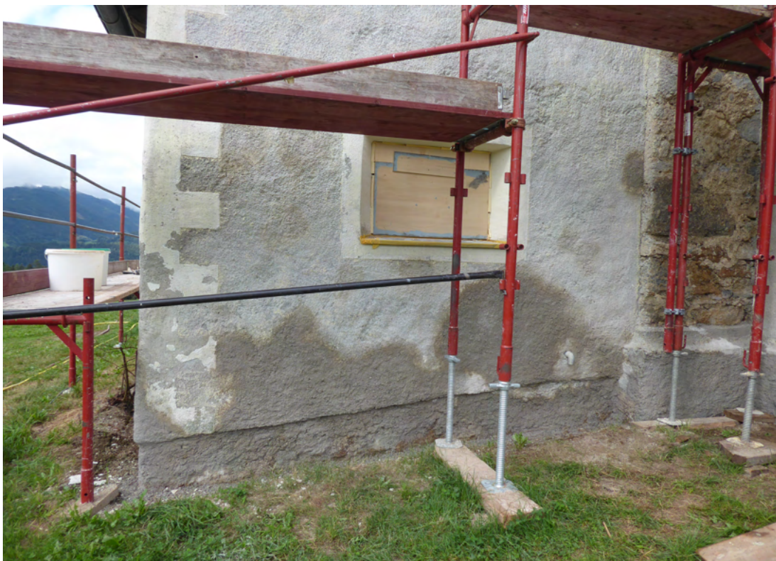
Bild 9 oben: Abnahme loser Putztaschen, Zementausbesserungen und Vorreinigung Sockelbereich zur Rückseite der Sakristei. Bild 10 unten: Beginn der Putzausbesserungen mit gleichwertigem Material.
