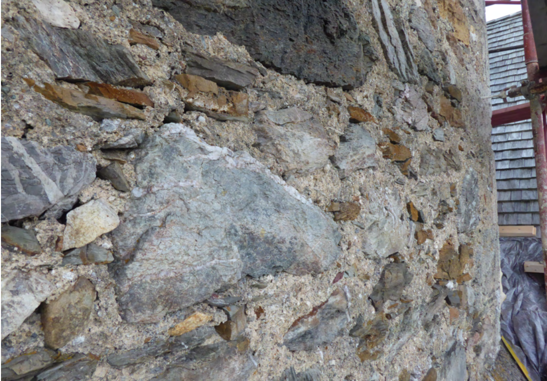
Bild 24 oben: Detailansicht Turmseite Süd mit reduzierter Putzlage (Bündige Verbindung zw. Setz- und Fugenmörtel) in dem ablaufendes Regenwasser immer weiter in den Verbund eindringen kann. Bild 25 unten Detailansicht Mauerwerksverbund Turmseite Nord mit gleichem Schadensbild wie Ansicht oben.
