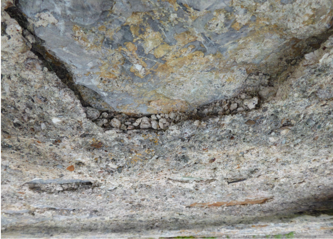
Bild 22 oben Detailansicht Turmseite Nord mit den noch erhaltenen Putzlagen. In den Öffnungen der Putztaschen lagert sich der Kies und Sand des abgebauten Mauer Mörtels ab.
