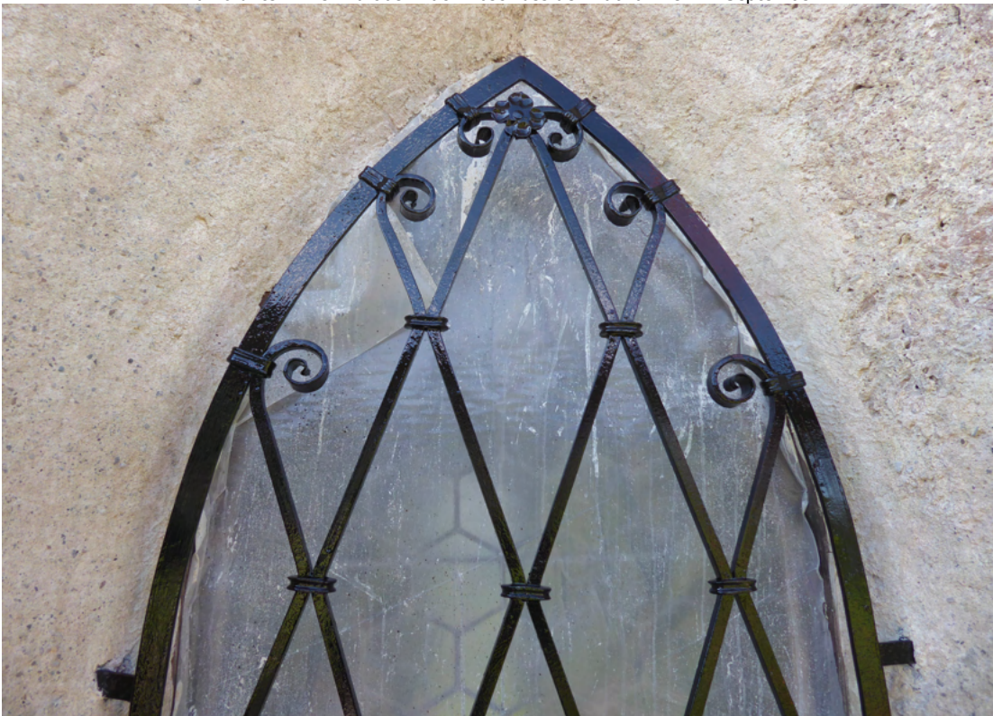
Bild 19 oben: Detailansicht Gitter, Spitzbogen über der Sakristei vor Reinigung und Anstrich mit pigmentiertem Öl Bild 20 unten: wie Bild oben nach Abschluss der Maßnahmen im September.
