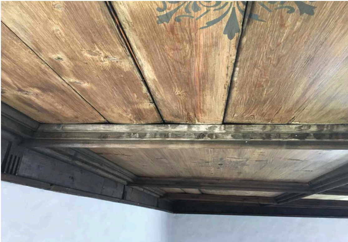
Bild 15 oben: Fassungssehäden an den Profilrahmen der Kassettendecke durch eindringendes Regenwasser Bild 16 unten: Retusche des gereinigten Bereiches
