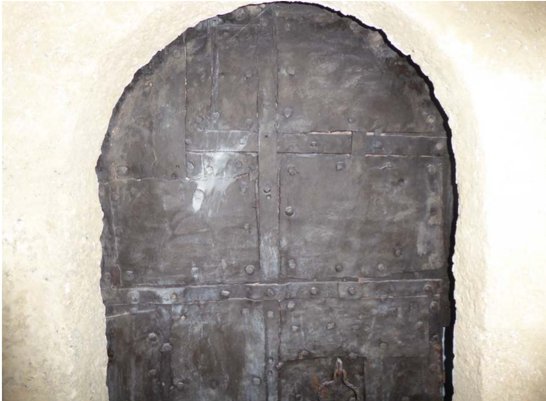
Bild 19 oben: Detailansicht Türblatt zum Turmzimmer vor der Reinigung Bild 20 unten: Detailansicht Türblatt zum Turmzimmer und Neufassung mit pigmentiertem Öl
