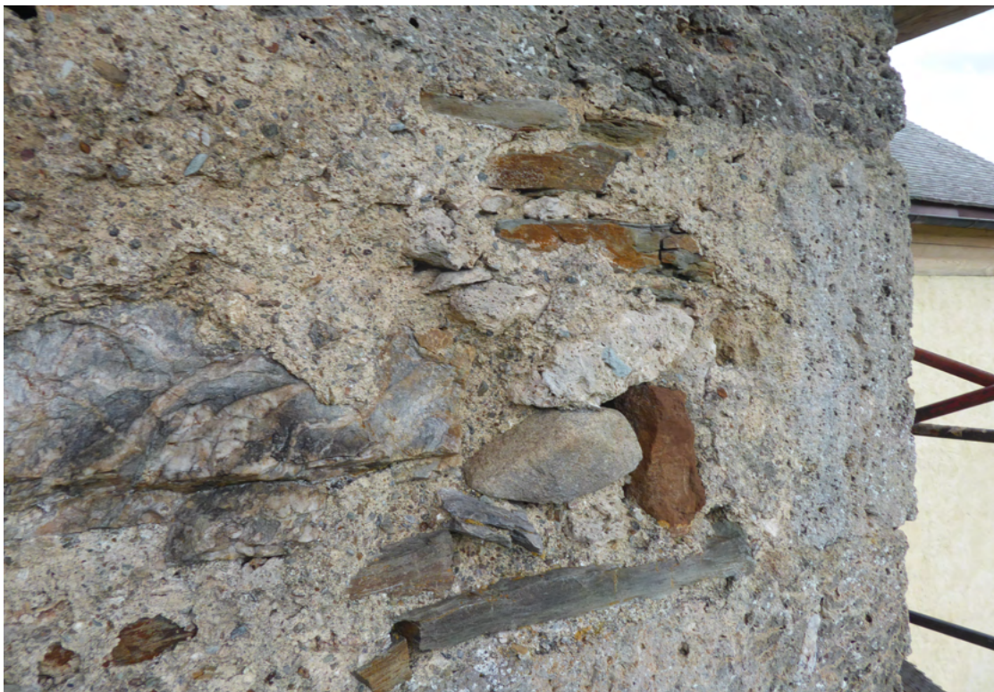
Bild 24 oben: Detailansicht Turmseite Süd mit reduzierter Putzlage (Bündige Verbindung zw. Setz- und Fugenmörtel) in dem ablaufendes Regenwasser immer weiter in den Verbund eindringen kann. Bild 25 unten Detailansicht Mauerwerksverbund Turmseite Nord mit gleichem Schadensbild wie Ansicht oben.
