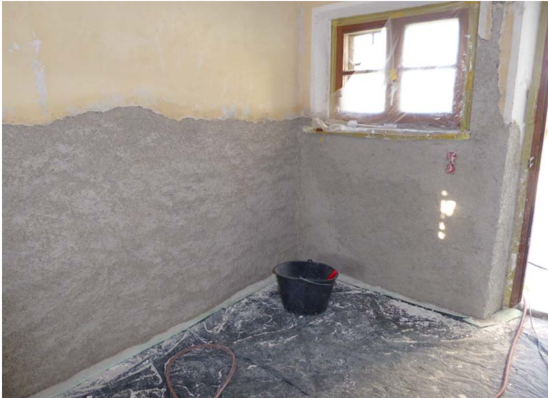
Bild 10 oben Ansicht Wandfläche Südwest: Neuperputzung mit Zuschlag von Berlit im Kalkmörtel für die bessere Pufferung von Salzen im Mauerwerk
