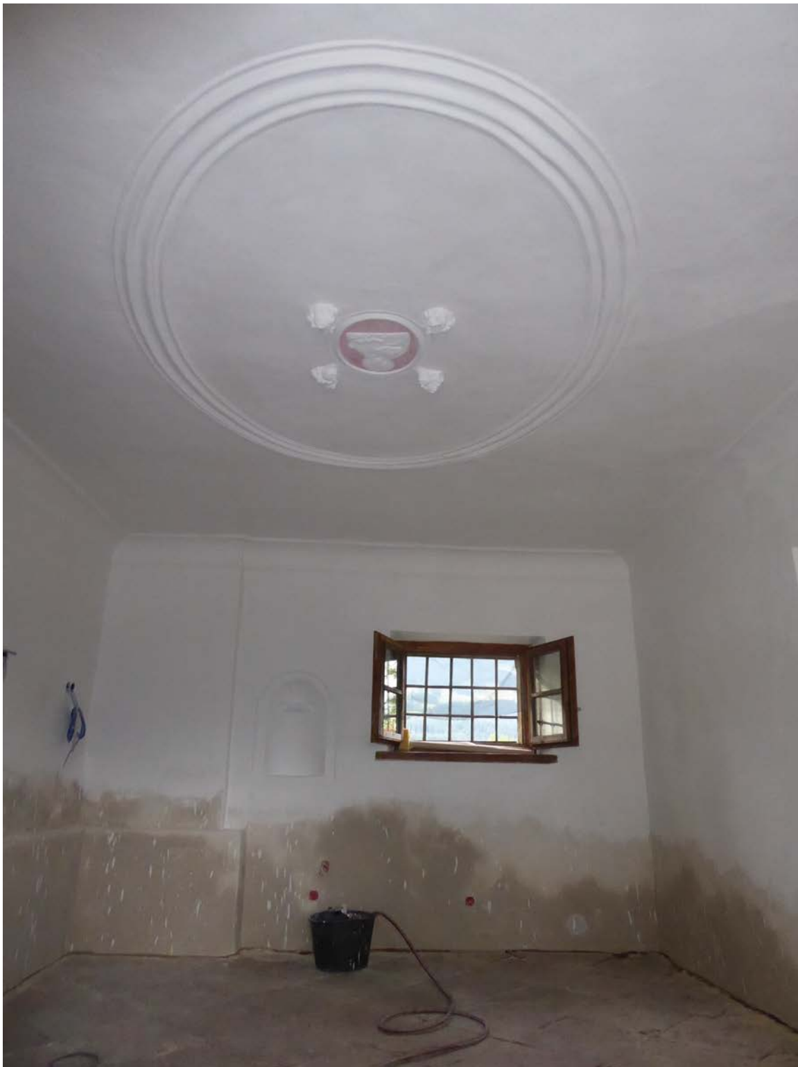
Bild 12 Gesamtansicht Wand- und Deckenfläche Sakristei Ost: Nach Abschluss der restauratorischen Maßnahmen im Sakristeianbau, Putzenerneuerung des Sockelputzes und bündiger Anschluss zum Bestand, partielle Nachbearbeitung des ovalen Stuckrahmens der Deckenfläche. Wand- und Deckenfläche wurden in monochrom weiß getüncht, Retusche der Nullfläche des Medaillons in Rosa. Der Letzte Anstrich erfolgte nach einer weiteren Austrocknungsphase Ende September.
