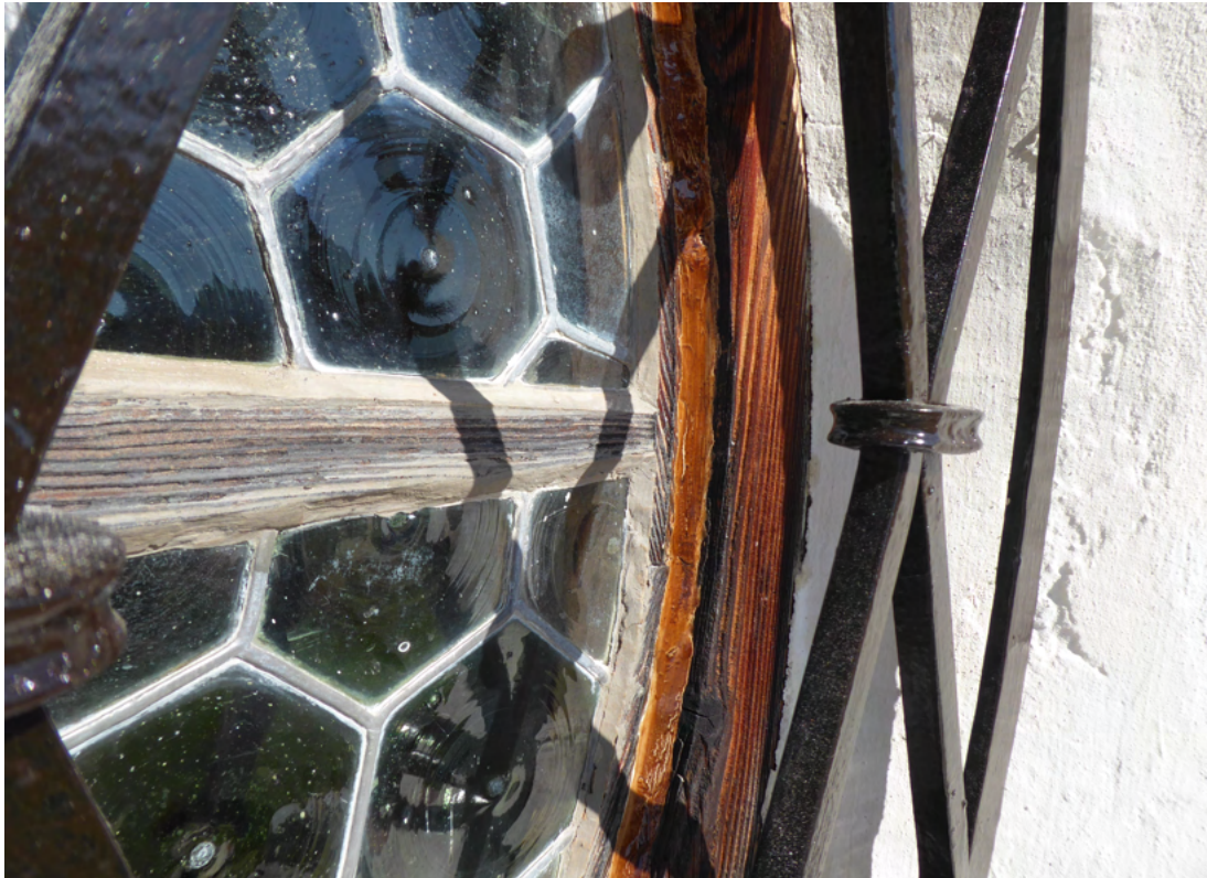
Bild 21 oben: Detailansicht Rundbogenfenster Fassade Süd nach Abschluss der Maßnahmen. Der Anschluss des Fensterflügels zum Fensterstock wurde mit Leinölkitt (eindringendes Regenwasser in den Kirchenraum) verschlossen und mitgefasst. Bild 22 unten: Türflügel nach Abschluss der Maßnahmen (Anstrich mit Leinöl) im September.
