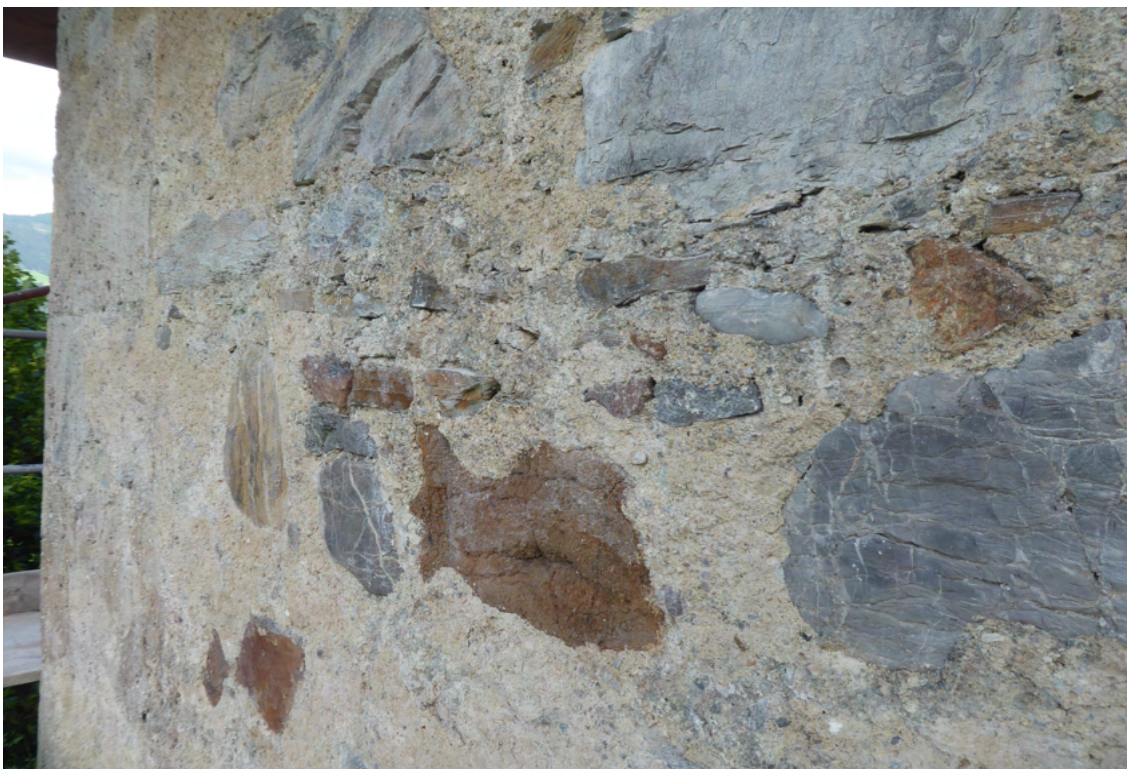
Bild 37 unten Detailansicht Nord: wie Bild oben nach Abschluss der Maßnahmen im Juli 2020.
