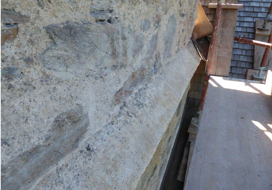
Bild 36 oben Detailansicht Turmseite West: Geschlossener Mauerwerksverbund und Ergänzung des umlaufenden Gesimses.
