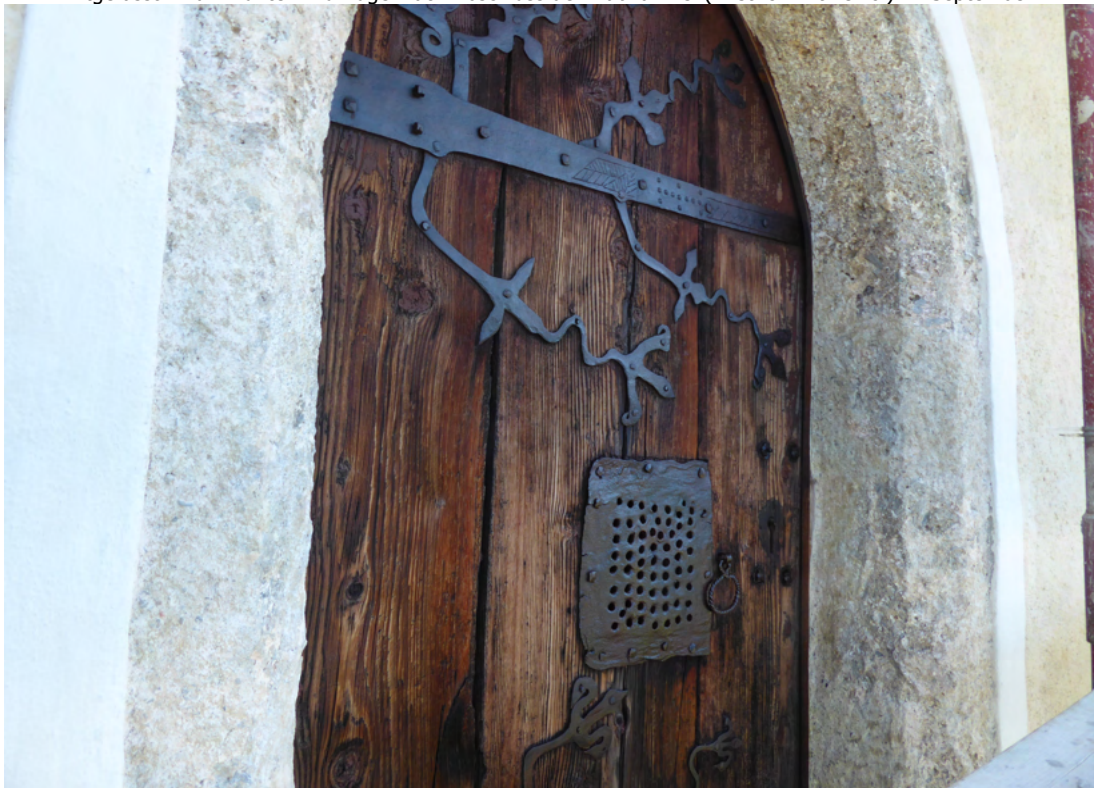
Bild 21 oben: Detailansicht Rundbogenfenster Fassade Süd nach Abschluss der Maßnahmen. Der Anschluss des Fensterflügels zum Fensterstock wurde mit Leinölkitt (eindringendes Regenwasser in den Kirchenraum) verschlossen und mitgefasst. Bild 22 unten: Türflügel nach Abschluss der Maßnahmen (Anstrich mit Leinöl) im September.
