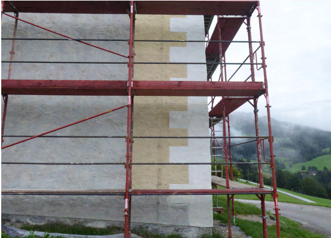
Bild 5 oben: Ansatz von mehreren Farbmusterflächen in reinem pigmentiertem Kalk und Zuschlag von 10% Steinmehl und 5% Plastorit. Bild 6 unten: Langhaus von Nordwest nach der Ausgerüstung im September.
