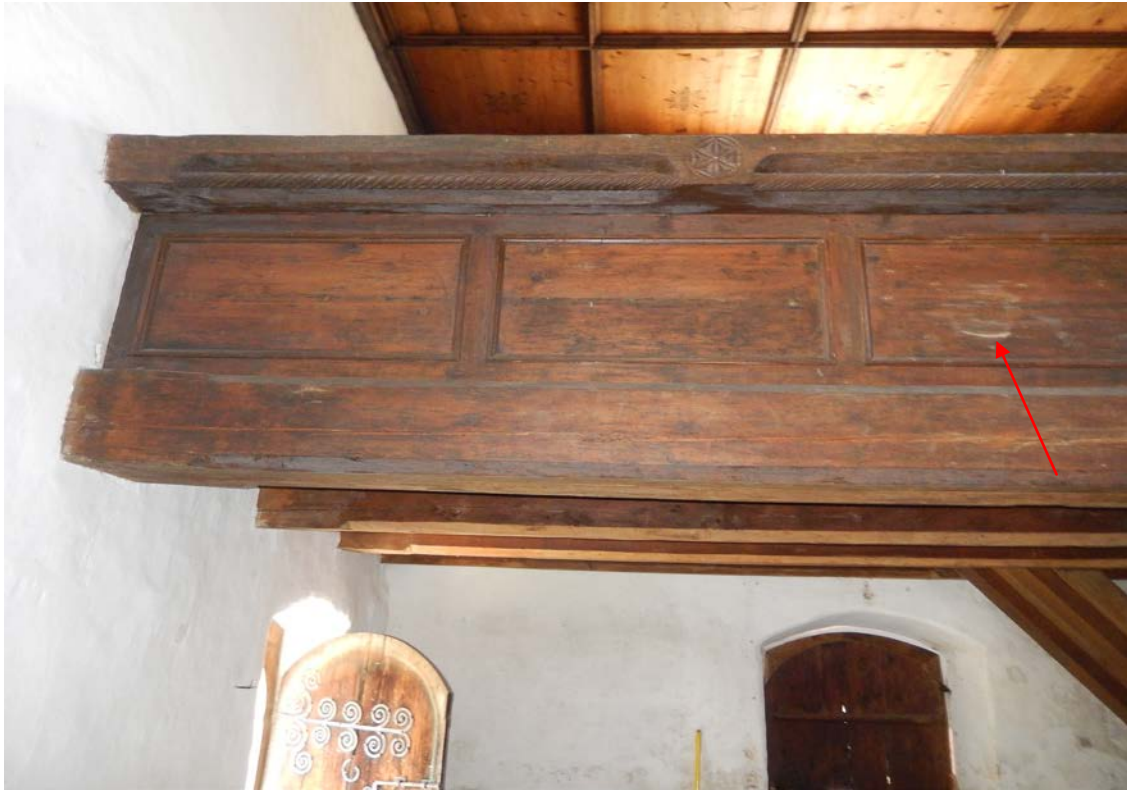
Bild 17 oben: Detailansicht der Empore vor der Trockenreinigung und Retusche der Schäden(Pfeil rot) Bild 18 unten: Gesamtansicht der Empore nach Abschluss der Maßnahmen
