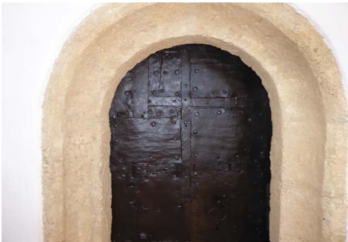
Bild 19 oben: Detailansicht Türblatt zum Turmzimmer vor der Reinigung Bild 20 unten: Detailansicht Türblatt zum Turmzimmer und Neufassung mit pigmentiertem Öl
