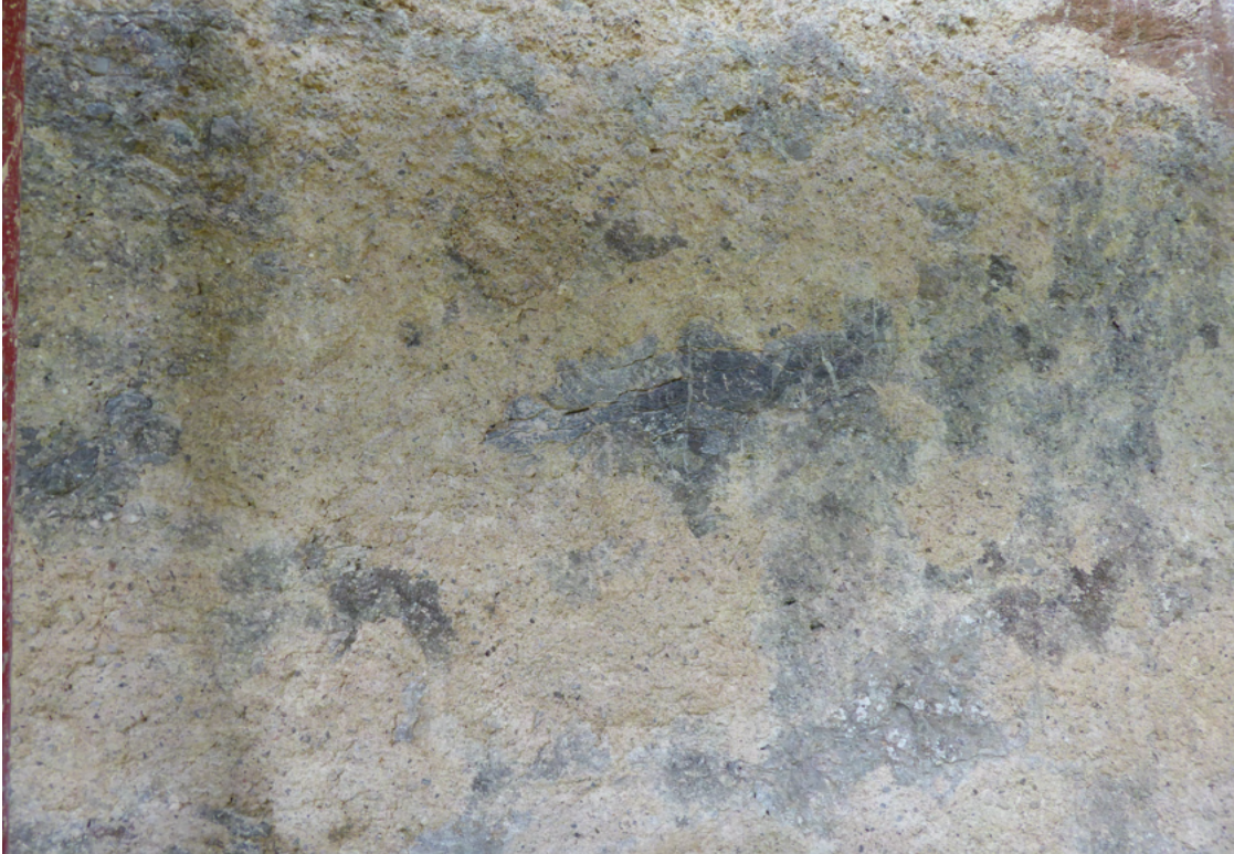
Bild 30: Detailansicht EG Mauerfläche Ost nach Angleichung der Textur zum gealterten Bestand des Mauerwerks. Bild 31 unten: Detailansicht Turmseite Ost nach Ausgerüstung und partieller Retusche der Ergänzungen (dunkle Flächen sind Stein und orig. bauzeitl. Sichtputzlage).
