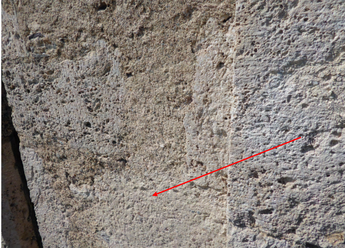
Bild 34 oben Detailansicht Turmseite Ost: Partielle Putzergänzung im Bereich der Klangarkade(siehe Pfeil). Bild 35 unten: Ergänzung des Gesimses nach Abschluss der Maßnahmen im September.
