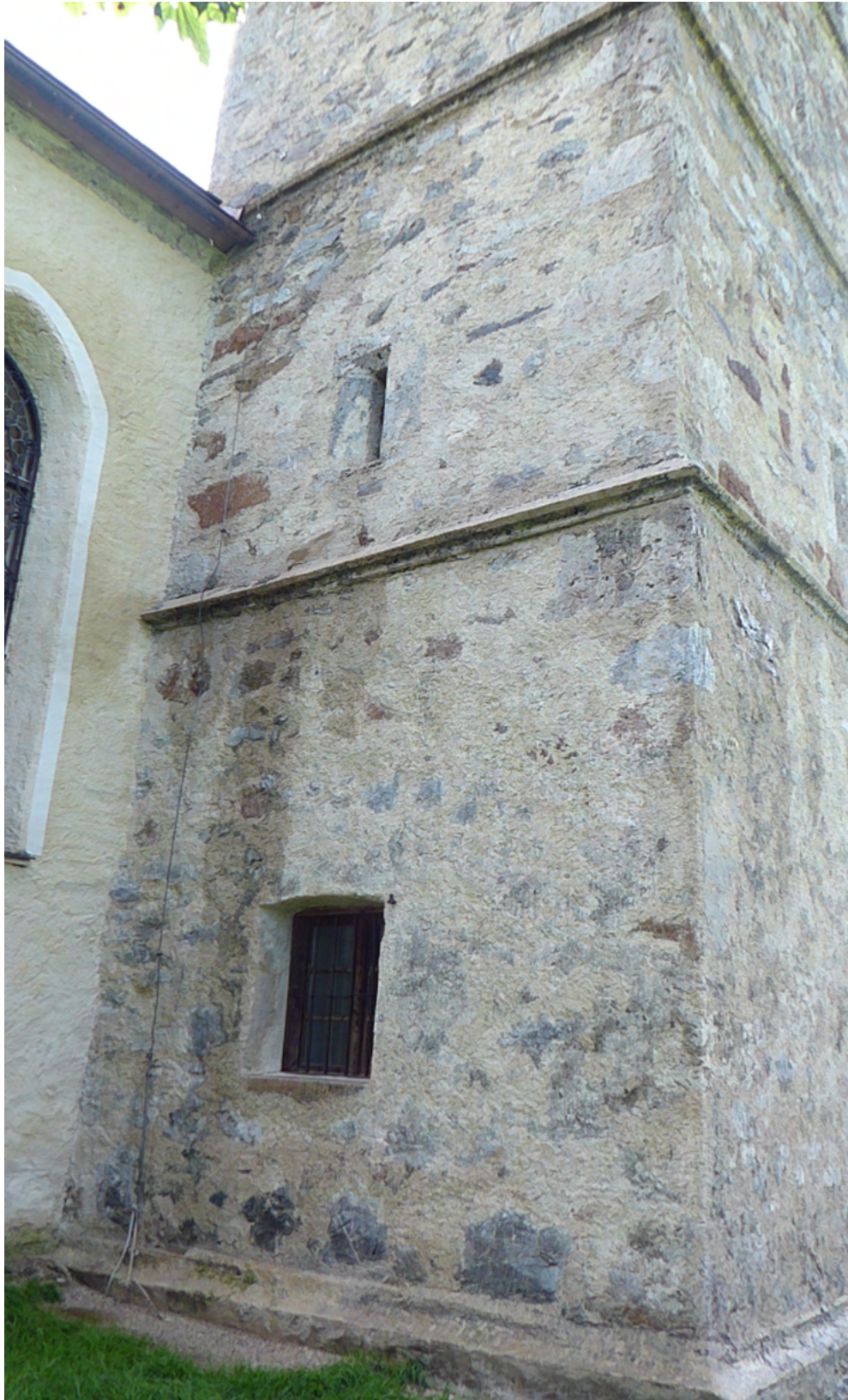
Bild 43: Detailansicht der Ostseite nach Abschluss der Maßnahmen im Sommer 2020(Die dunklen Bereiche sind auf ablaufendes Regenwasser zurückzuführen).
