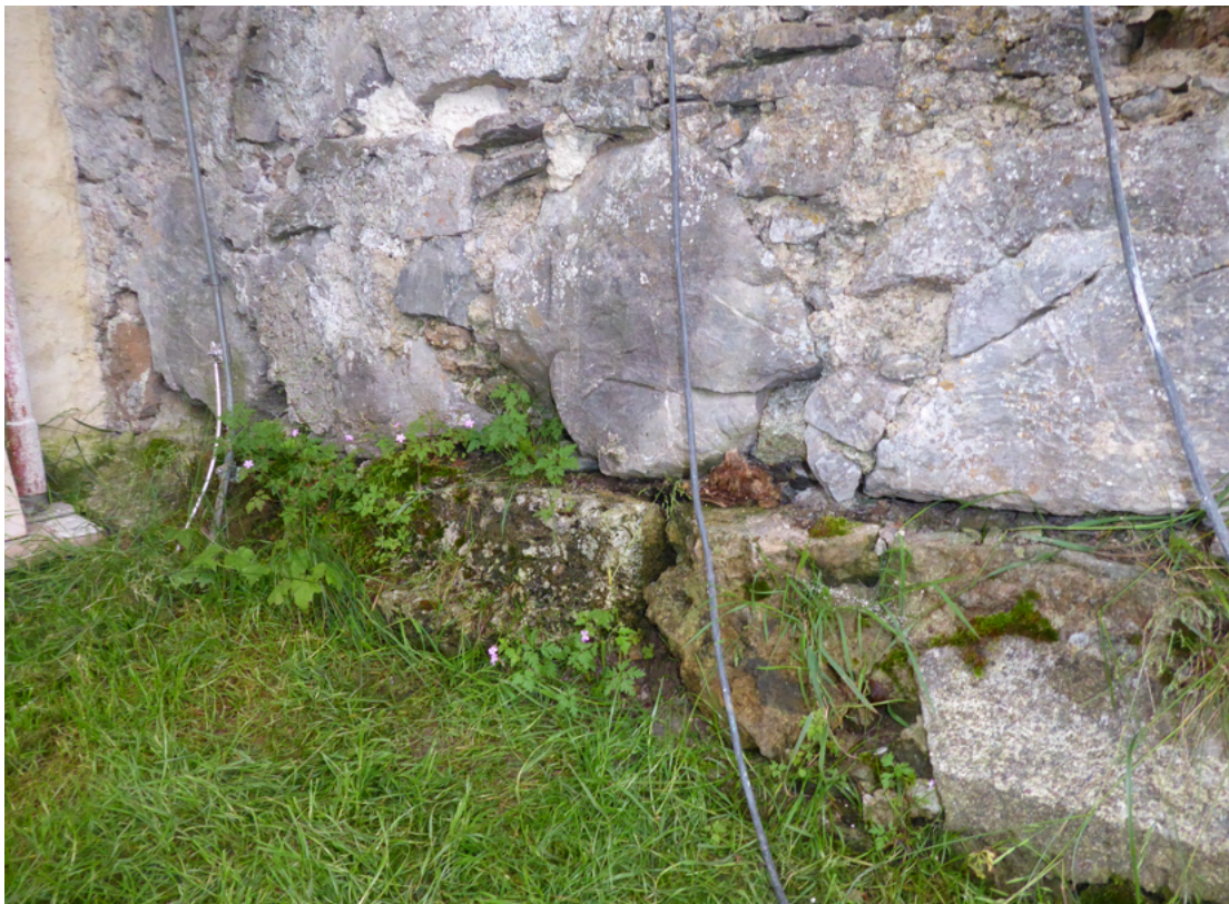
Bild 16 oben Detailansicht Turmseite Nord: Pflanzenbewuchs unterhalb des ersten umlaufenden Gesimses. Bild 17 unten Detailansicht Sockelbereich Ost mit abgestorbenen Wurzelresten im Mauerwerk.
