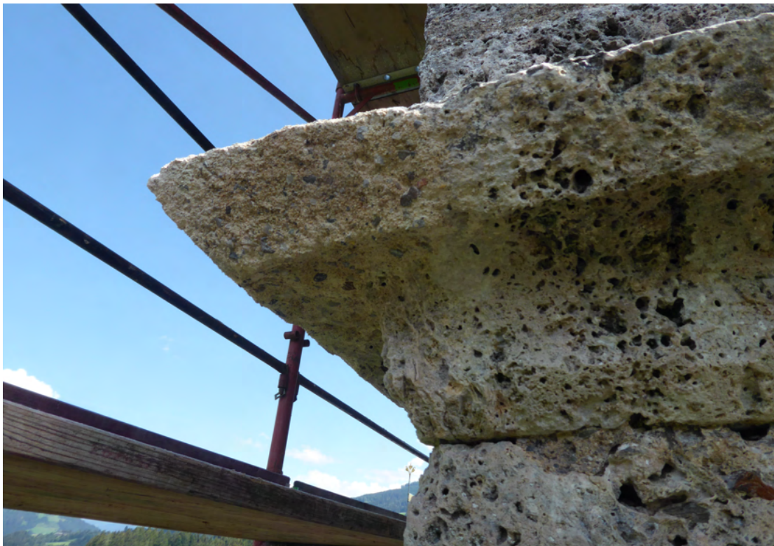
Bild 34 oben Detailansicht Turmseite Ost: Partielle Putzergänzung im Bereich der Klangarkade(siehe Pfeil). Bild 35 unten: Ergänzung des Gesimses nach Abschluss der Maßnahmen im September.
