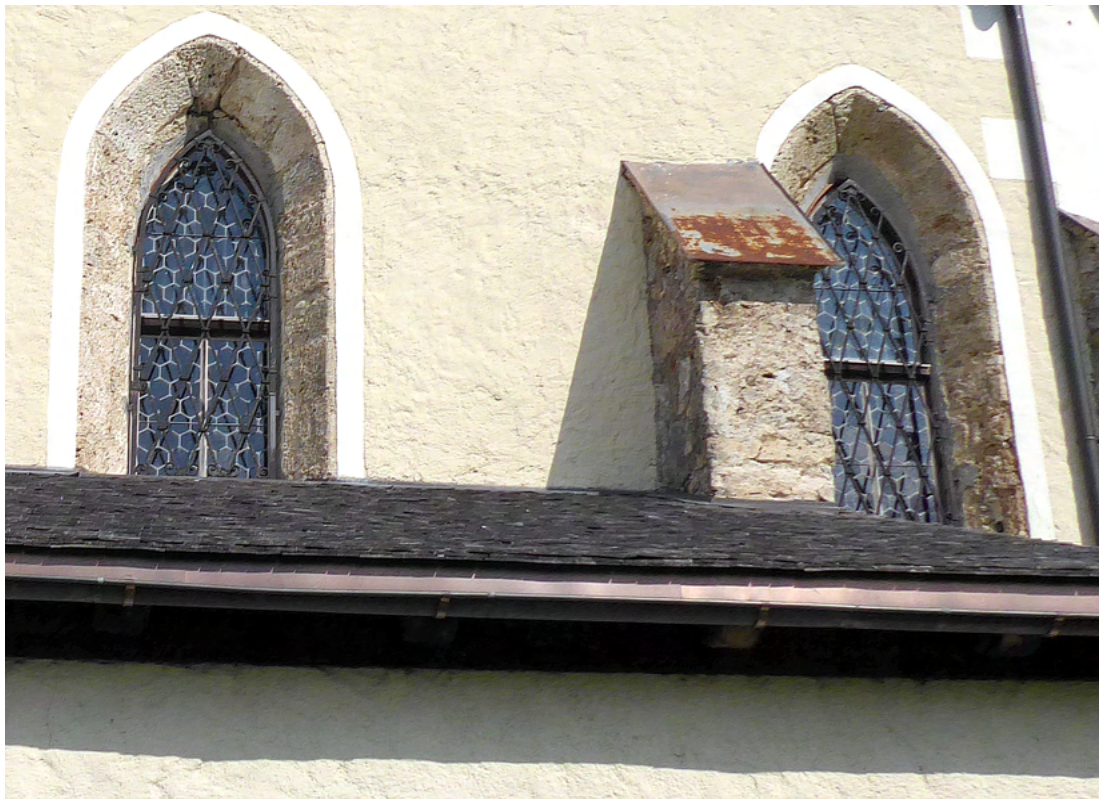
Bild 7: Referenzbereich Wandfläche Süd, Detailbereich Laibung der Fenster über Sakristei im Vorzustand mit den Zementausbesserungen im oberen Spitzbogen. Bild 8 unten: Nach Abschluss der Maßnahmen, Risschließung, Angleichung der Textur und Farbe mit Kalkschlämme und Aqua Sporca.
