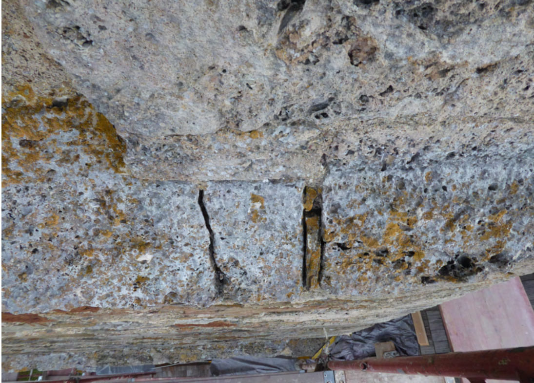
Detailansicht mittleres Gesimse Südseite Bild 20 vor den restaurator. Maßnahmen. Bild 21 Detailansicht Turmseite Nord mit Ausbesserungen der Fugen am Rundbogenfensters/Kapital aus der letzten Renovierungsphase.
