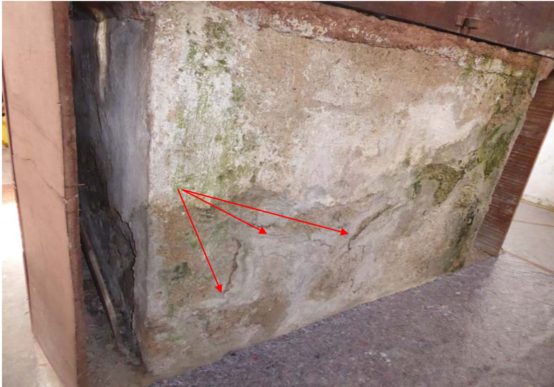
Bild 6 oben: Mensarückseite vor den restauratorischen Maßnahmen. Das sind Antimoosbehandlung der Sichtputzlage, Abnahme der Romankalkausbesserungen im Sockelbereich(Pfeile rot) und bündiges schließen der Fehlstellen mit Kalkmörtel. Textur des Fassungsträgers nach Vorgabe und bündig, angrenzend zum Bestande. Bild 7 unten: Nach Abschluss der Maßnahmen vor dem Kalkanstrich(Tünche Weiß).
