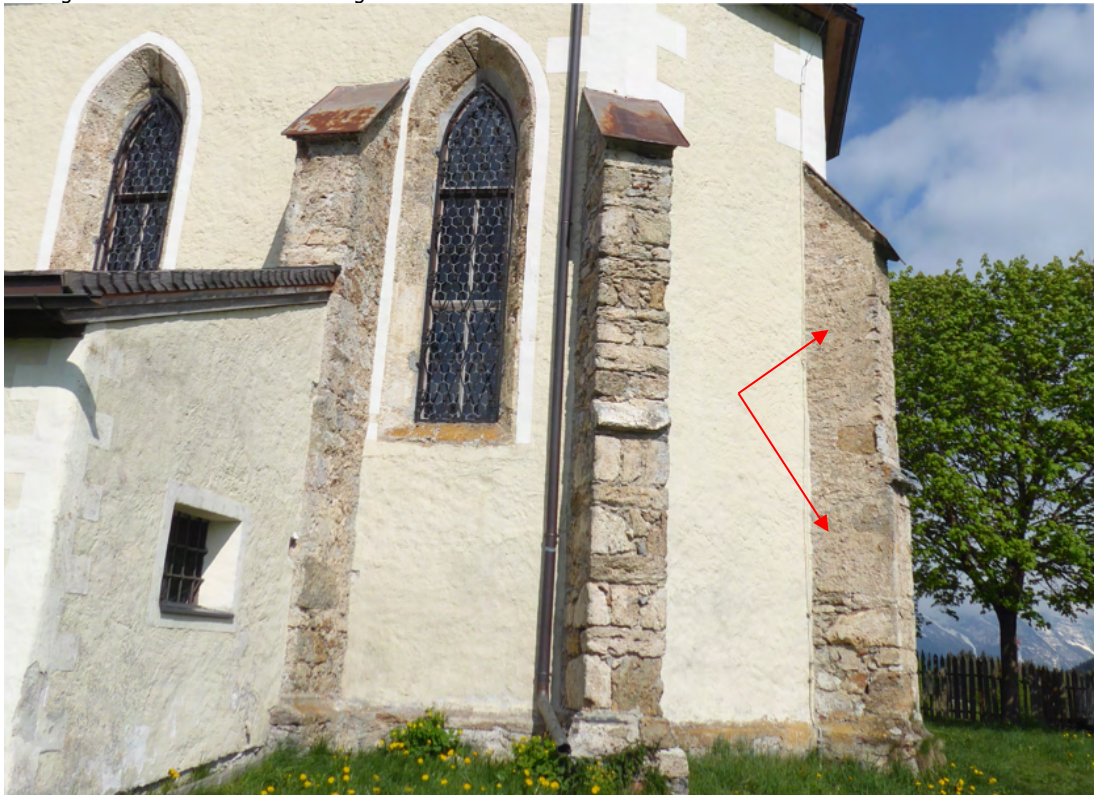
Bild 11 oben: Detailansicht Fassadenfläche der Sakristei nach Abnahme der Farbe und Abschluss der Putzergänzung. Bild 12 unten: Detailansicht Fassade Südost vor Beginn der Arbeiten. Vorgabe der Putzergänzungen am histor. Bestand ist ein noch gut erhaltener Putzbereich der got. Architekturoberfläche an einem der östl. Pfeiler.
