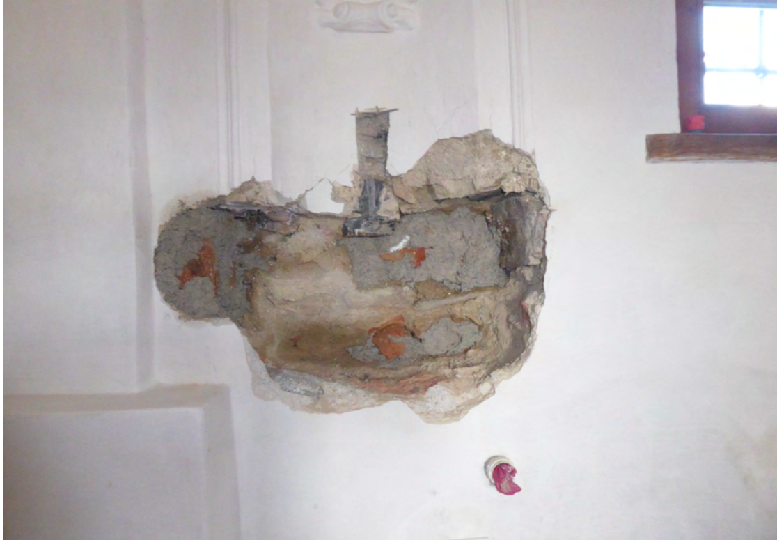
Bild 45 oben und Bild 46 unten: Einbau des Lavabos in der Sakristei. Hierfür wurde der Bereich für den Stein ausgestemmt und nach Montage wieder eingeputzt inkl. Anbindung der Stuckprofile und Feinputz. Fassung des Bereiches mit Kalktünche laut Bestand.
