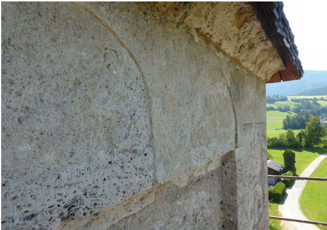
Detailansicht Turmseite Nord Bild 32 oben. Geschlossenen Putztaschen des bauzeitl. Bestandes und Vorbereitung für die Injektionsarbeiten (Die eingeputzten Buchenholzstäbchen dienen anschließend als Kanülen für den Injektionsmörtel, siehe Pfeil) Bild 33 unten: Detailansicht Turmseite West mit Rundbogenfries nach Abschluss der Ergänzungsarbeiten.
