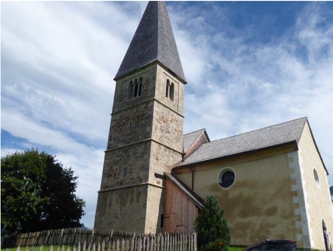
Bild 47: Gesamtansicht Nordwestseite nach Abschluss der Arbeiten(Witterungsbedingte Feuchtigkeitflecken auf der Fassade)
