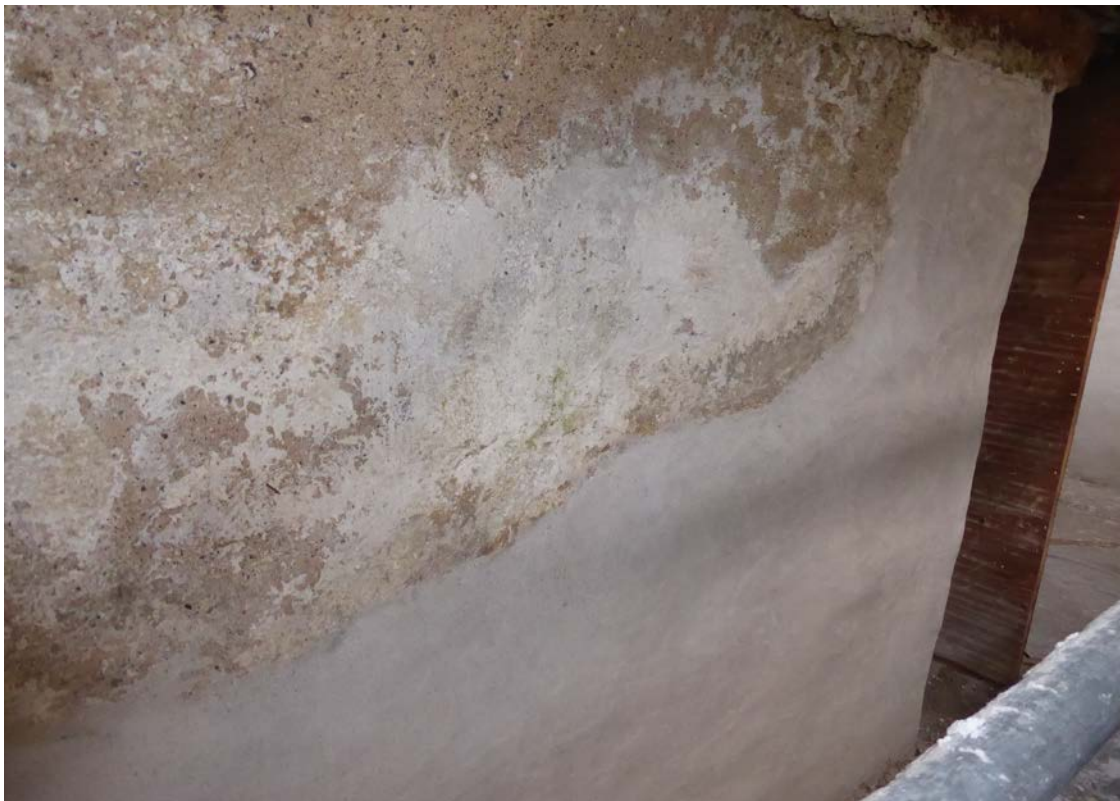
Bild 6 oben: Mensarückseite vor den restauratorischen Maßnahmen. Das sind Antimoosbehandlung der Sichtputzlage, Abnahme der Romankalkausbesserungen im Sockelbereich(Pfeile rot) und bündiges schließen der Fehlstellen mit Kalkmörtel. Textur des Fassungsträgers nach Vorgabe und bündig, angrenzend zum Bestande. Bild 7 unten: Nach Abschluss der Maßnahmen vor dem Kalkanstrich(Tünche Weiß).
