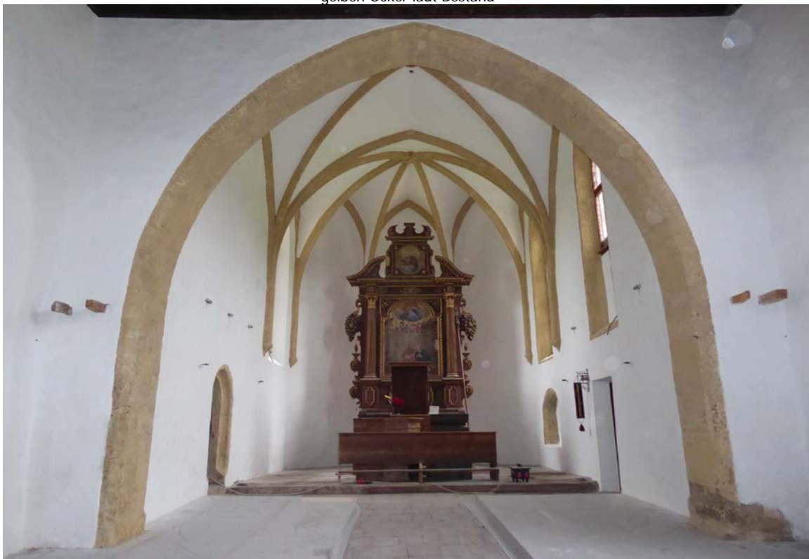
Bild 24 oben und Bild unten: Gesamtansicht Chorbogen und Apsis vor der Neufassung der Raumschale Bild 25 unten: Nach Abschluss der Neufassung Wandflächen monochrom in gebrochenem Weiß, steinsichtige Elemente in gelben Ocker laut Bestand
