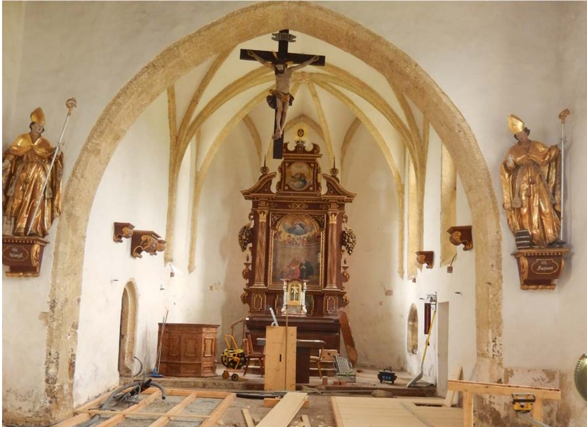
Bild 24 oben und Bild unten: Gesamtansicht Chorbogen und Apsis vor der Neufassung der Raumschale Bild 25 unten: Nach Abschluss der Neufassung Wandflächen monochrom in gebrochenem Weiß, steinsichtige Elemente in gelben Ocker laut Bestand
