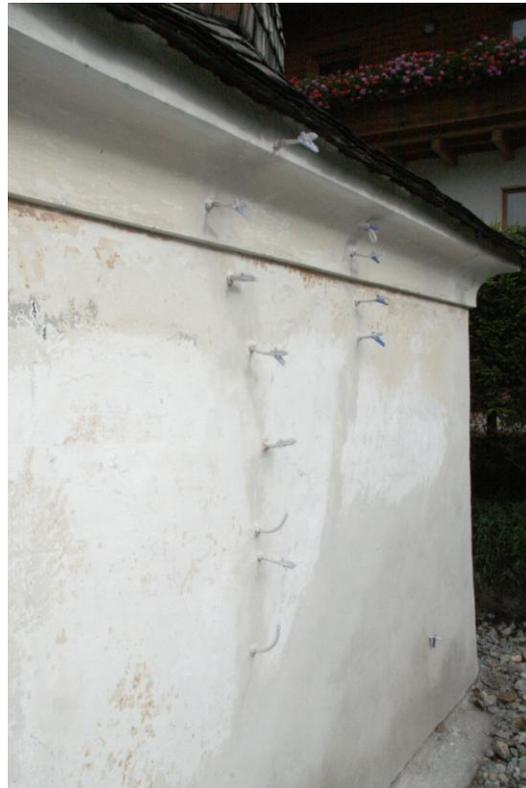
Im Zuge der Putzergänzungen und schließen der Risse wurden Kanülen für die nachfolgenden Injektionsarbeiten gesetzt. Risse und Hohlstellen wurden mit hydraulischem Injektionsmörtel aufgefüllt bzw. Putzsollen am Putzträger verklebt.
