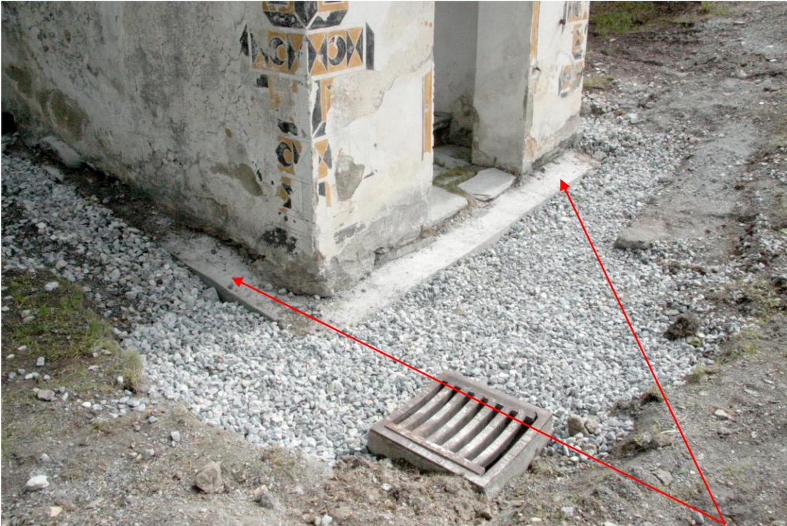
Vor Beginn der restauratorischen Maßnahmen wurde das Fundament der Kapelle mit einem stahlarmierten Betonkranz(siehe Pfeil rot) unterfangen und anschließend eine Drainagierung mit Rollkiesbeschüttung angelegt. Auch der Kanalanschluss für das Oberflächenwasser wurde neu gesetzt.
