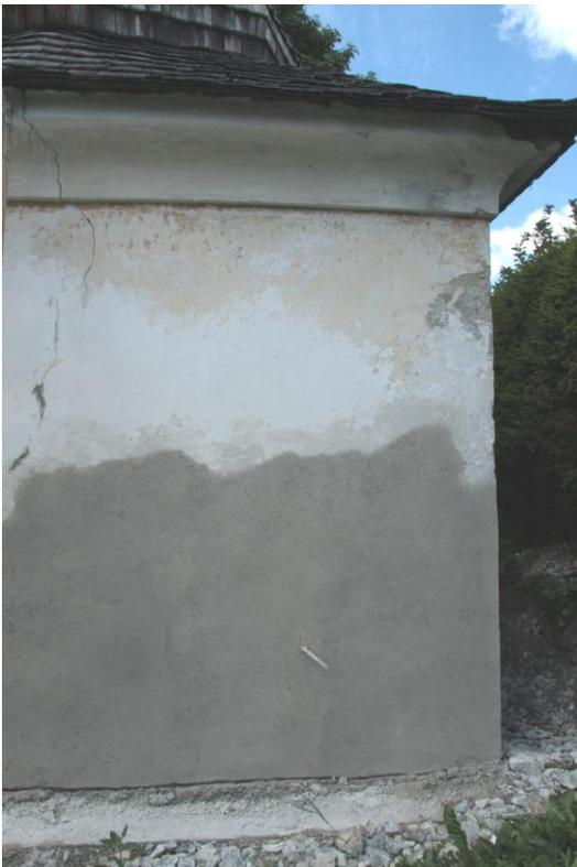
Nach Abnahme der zementhaltigen Sockelputze erfolgte das bündige Schließen der Flächen mit Kalkmörtel. In den Sockelzonen wurde zusätzlich mineralischer Berlit als Zuschlagstoff eingearbeitet um die Aufnahmefähigkeit von Salzphasen zu verbessern.
