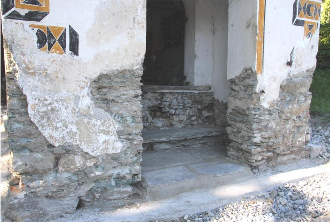
Bild oben; Ansicht West: Abnahme der Zementputze im Sockelbereich Außen und im Kapellenraum.
